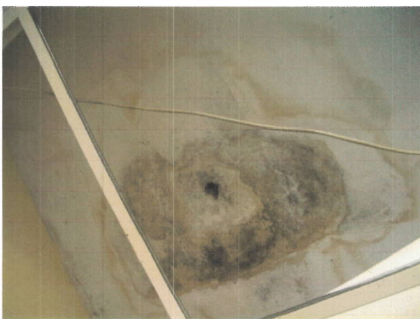
IMAGEN 25y 26 : Se observa las filtraciones en techo en el área de salud
