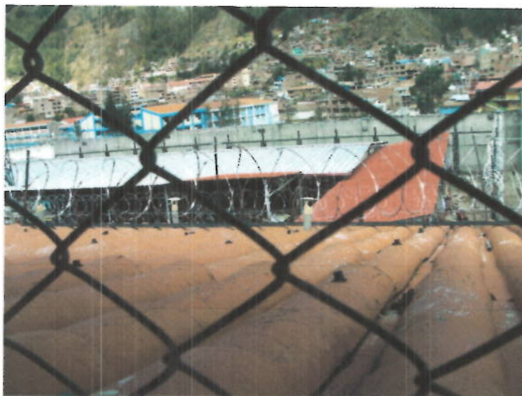
IMAGEN 33 : Se observa la cobertura de teja Eternit en habitación de agentes el cual genera filtraciones
