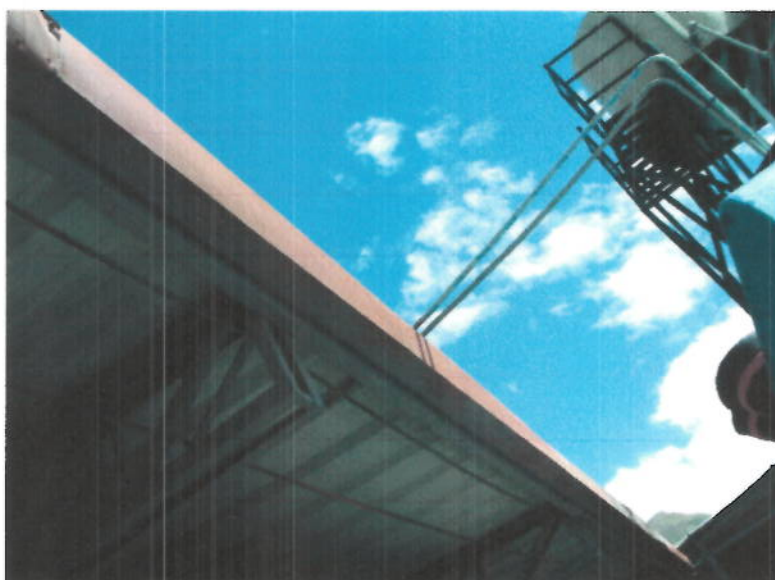
IMAGEN 19 y 20 : Se observa red de bajada (montante) y canaleta en condiciones adecuadas
