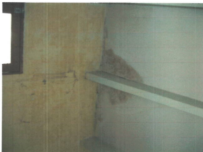
IMAGEN 21y 22 : Se observa las filtraciones en techo en el área de habitación de agentes
