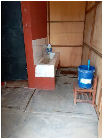
FOTO N°05: Se muestra el interior del SS.HH., con tabiques de triplay.
