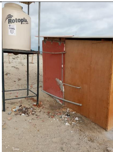
FOTO N° 06: Se muestra el tanque prefabricado para el almacenamiento del agua.
