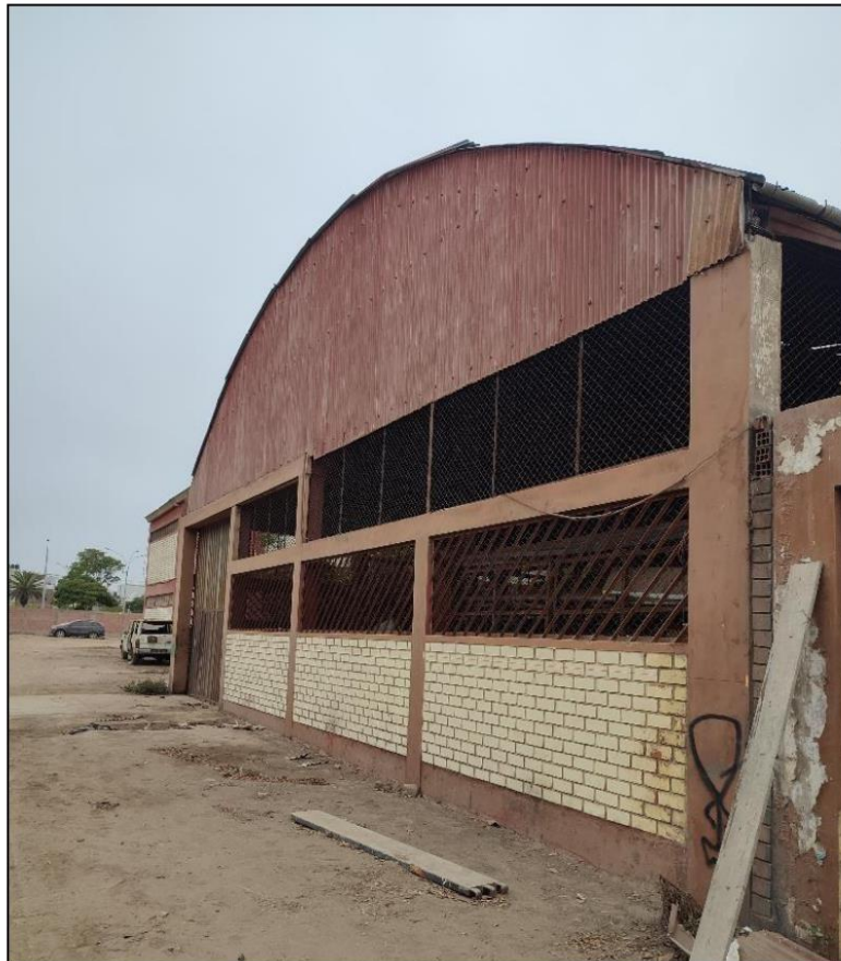
Figura 18. Cerramiento vertical en zona curva de cobertura.
