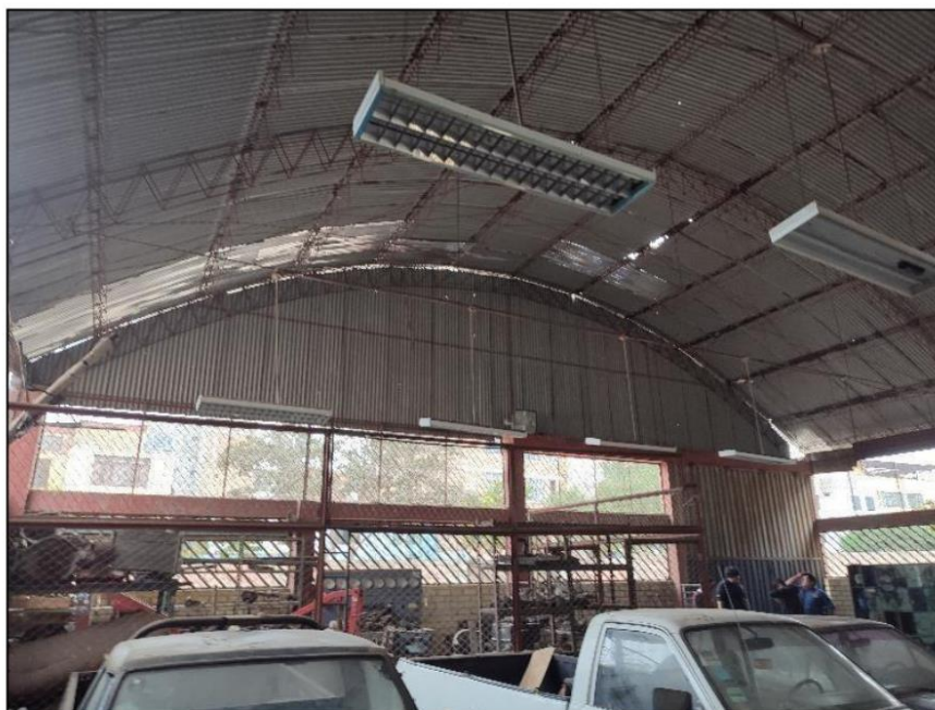
Figura 19. Cobertura desde el interior (se aprecia el sistema estructural de la misma).
