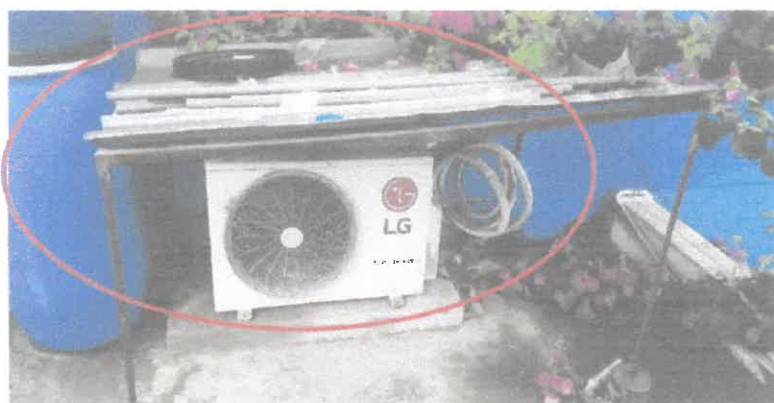
Foto N°17: Vista del 3er piso donde se encuentran los condensadores de los aires acondicionados, los cuales necesitan protección para evitar que sufran desperfectos.
