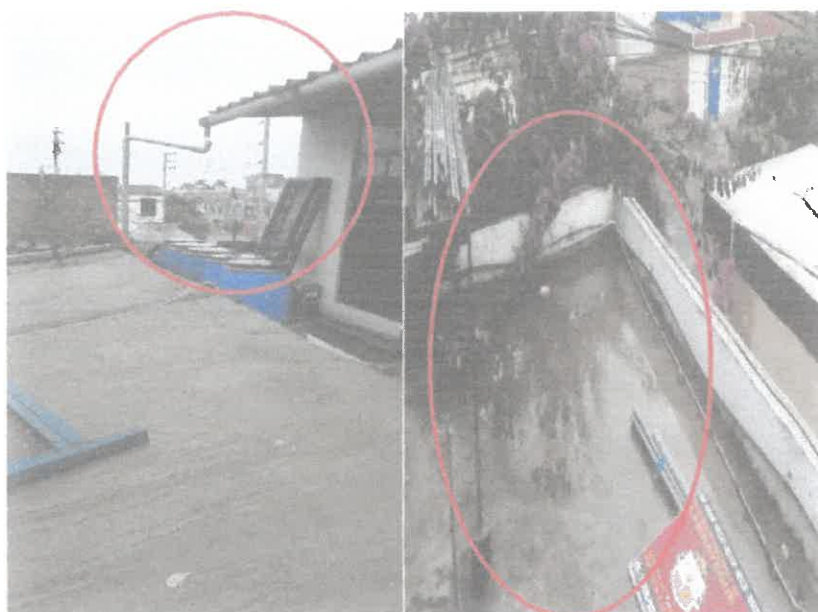
Foto N°16: Vista del 3er piso donde se encuentra agua almacenado debido a un sistema de drenaje pluvial del techo que se encuentra averiado. Lo que ocasiona daños a los elementos estructurales de la infraestructura.
