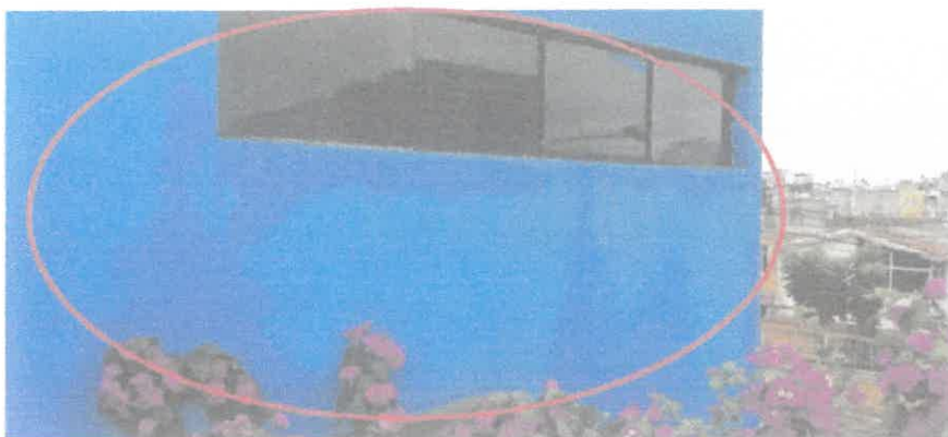
Foto N°18: Vista del 3er piso donde se encuentra la oficina de Archivo, afectado por la lluvia en los muros que son de material Drywall.
