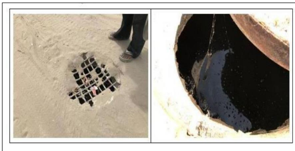
Imagen N° 25 : Buzones con tapas rotas e inundados
