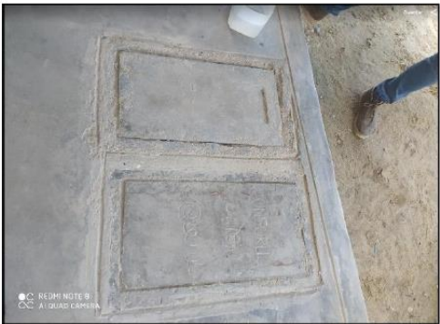
Imagen N°31: Cajas de desagüe con tapa de concreto
