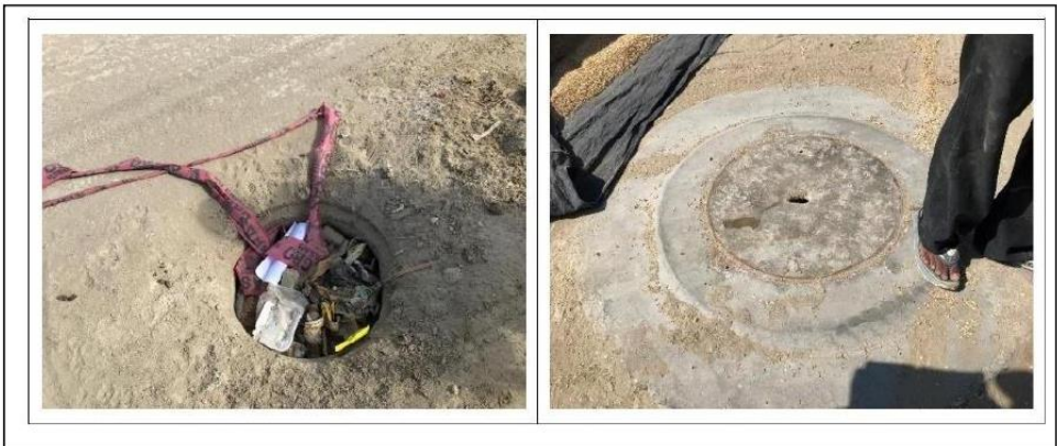
Imagen N°28: Buzones llenos de agua y basura, tapas con agujeros
