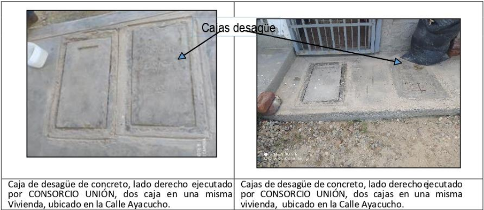
Imagen 13: Conexiones domiciliarias de desagüe
