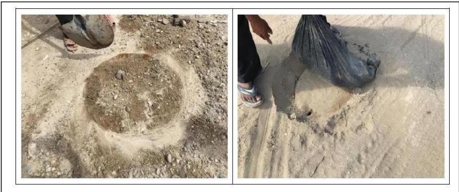
Imagen N°29: Buzones enterrados con tapas en mal estado
