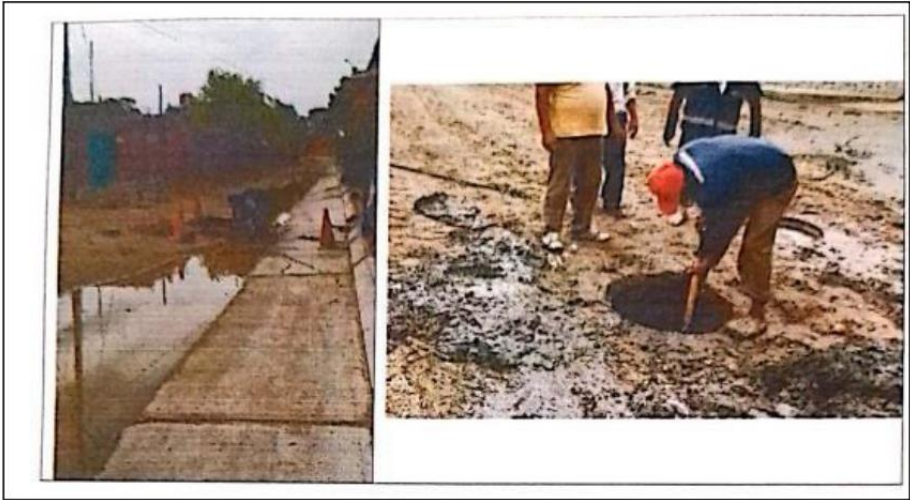
Imagen N°26: Buzones desbordados y colmatados, tapas rotas y maleza
