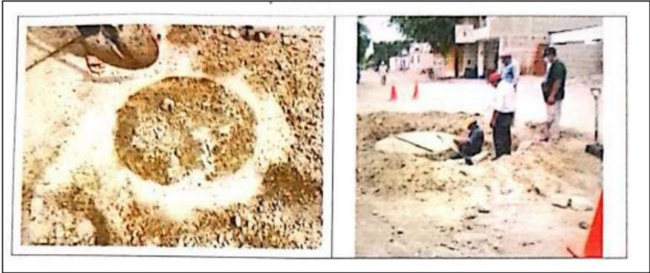
Imagen N°30: Buzones enterrados con tapas en mal estado
