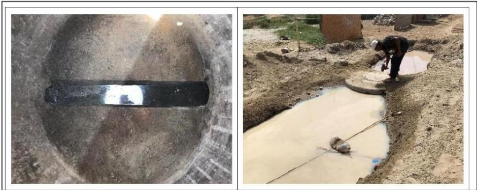
Imagen N°27: Buzones con tapas enterrados
