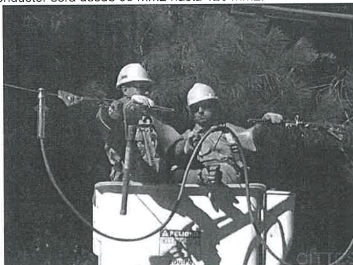
Imagen N° 01: Reemplazo de conductor averiado (fuente: Congreso Internacional de Trabajos con Tensión)
