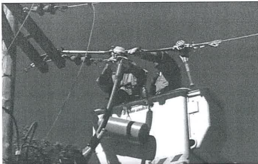
Imagen N° 01: Reemplazo de cadena de aisladores (fuente: Congreso Internacional de Trabajos con Tensión)
