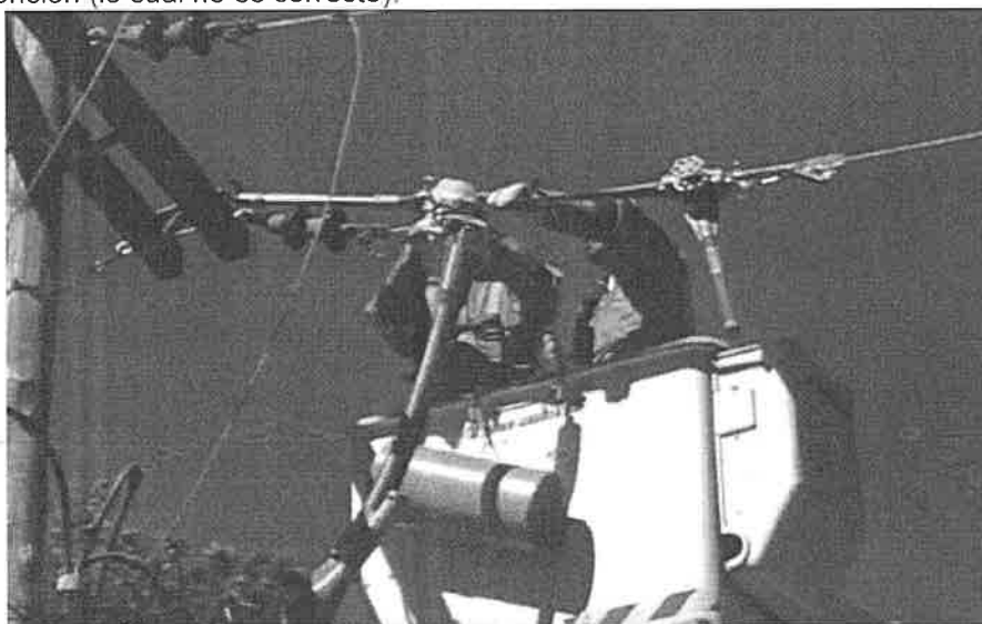
Imagen N° 01: Instalación de cadena de aisladores (fuente: Congreso Internacional de Trabajos con Tensión)
