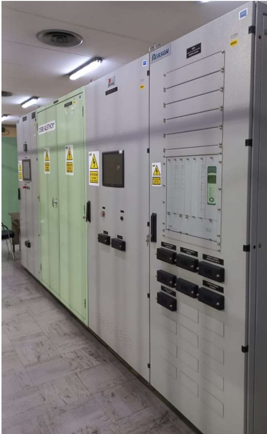
Ubicación de los Tableros Registradores Digitales de Falla – Casa de Maquinas Charcani V
