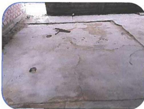
Fotografía N° 06.- Estado actual del piso existente, presenta fisuras y desniveles.
