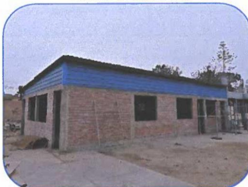
Fotografía N° 01.- Vista frontal del Laboratorio de Construcción Civil, presenta muros perimetrales de albañilería confinada de 15cm con cobertura liviana.
