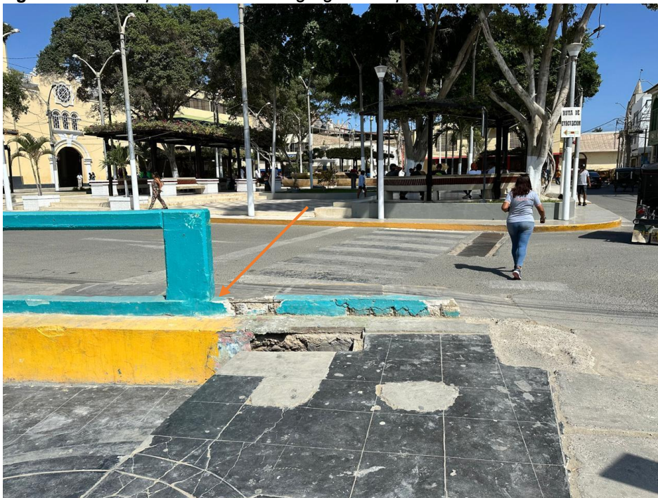
Imagen N°03: Gradas agrietadas Zona Zanjón.
