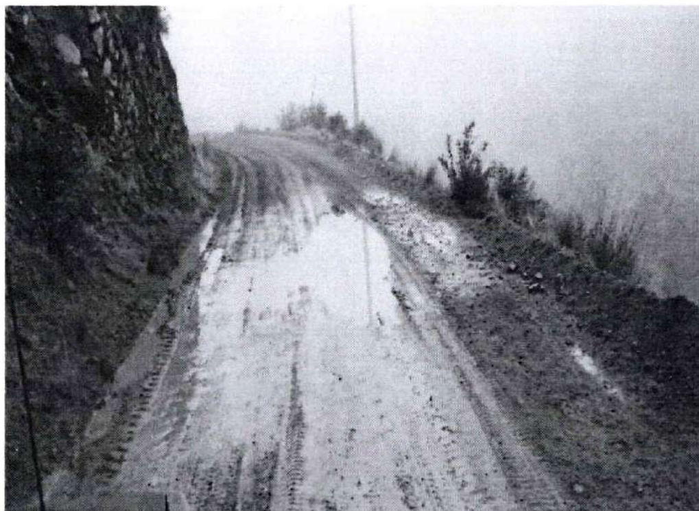
KM. 68+600 SE APRECIA LODAZAL EN LA CALZADA POR LLUVIAS EN EL TRAMO.
