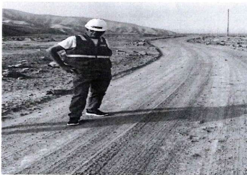
KM. 13+450 FALTA COMPACTACION EN LA SUPERFICIE RODADURA.
