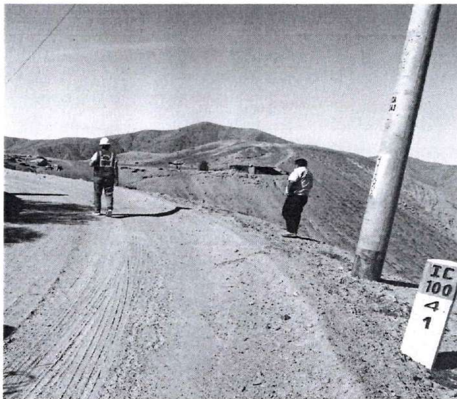
KM.41+000 INADECUADA COMPACTACION EN LA CALZADA.
