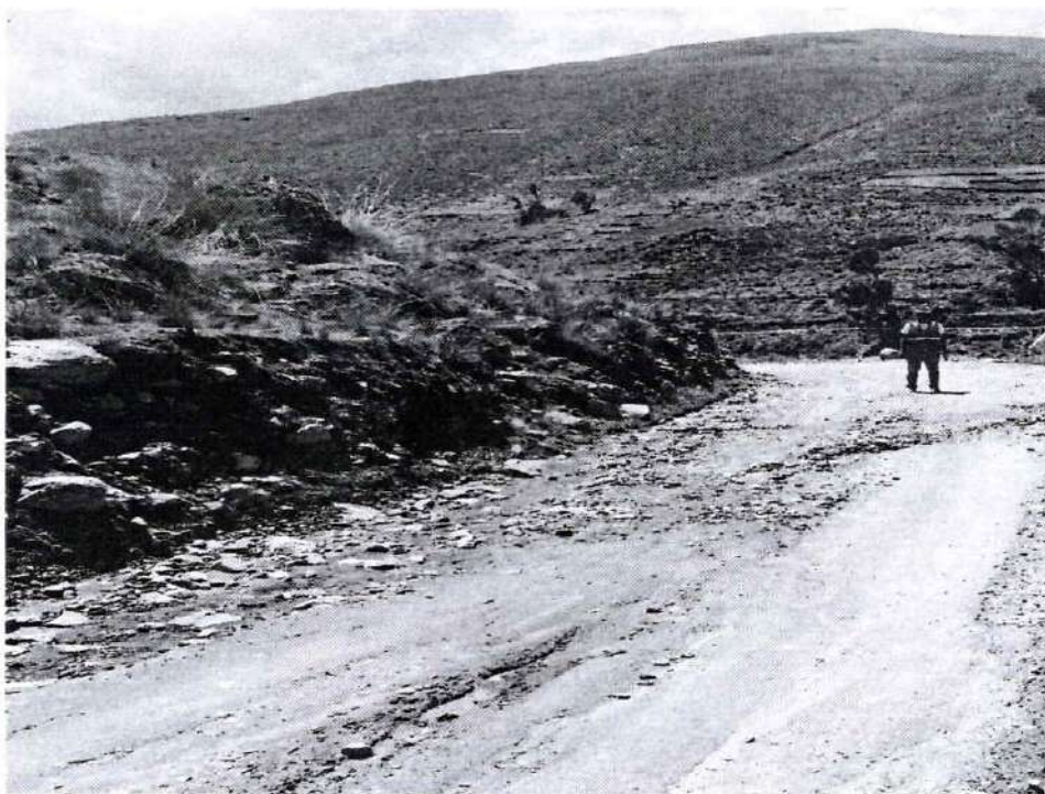
KM. 90+000 SUPERFICIE DE RODADURA EROSIONADA A CAUSA DE CUNETAS COLMATADAS.
