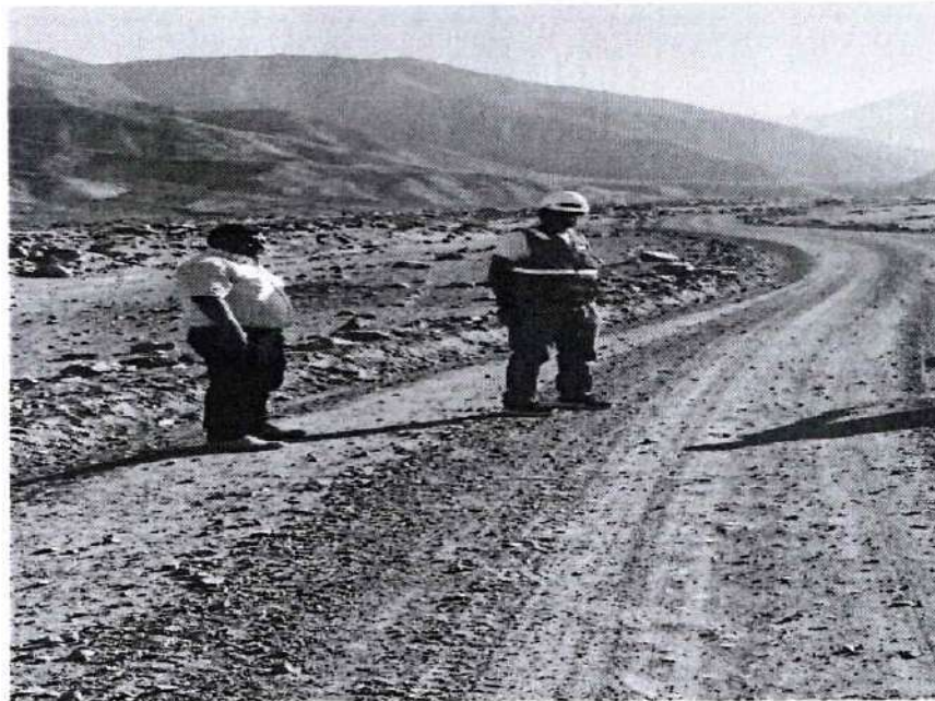
KM. 20+00 SE APRECIA ENCALAMINADO Y MATERIAL SUELTO EN CALZADA
