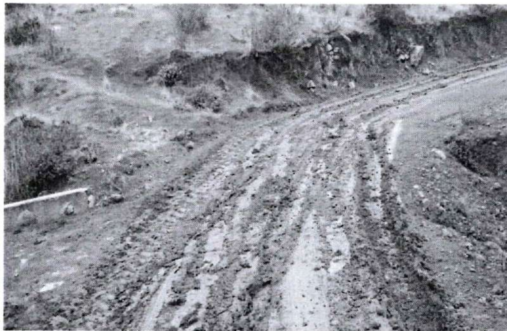
KM. 67+350 MATERIAL SUELTO EN SUPERFICIE DE RODADURA.
