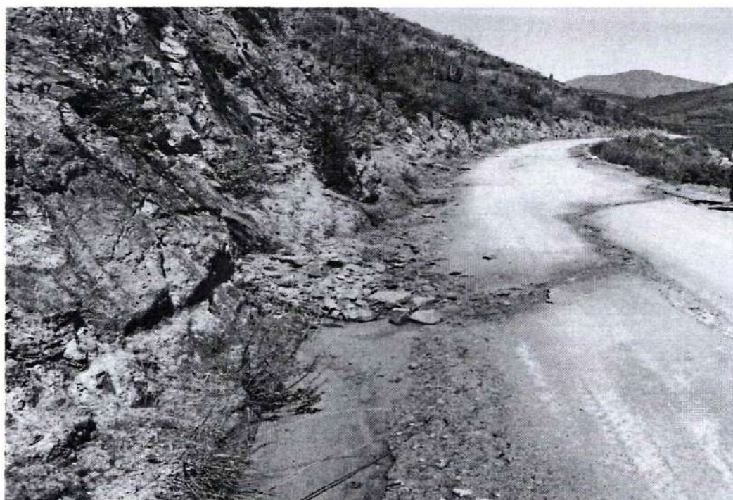
KM. 89+500 SUPERFICIE DE RODADURA EROSIONADA DEBIDO A CUNETAS COLMATADAS
