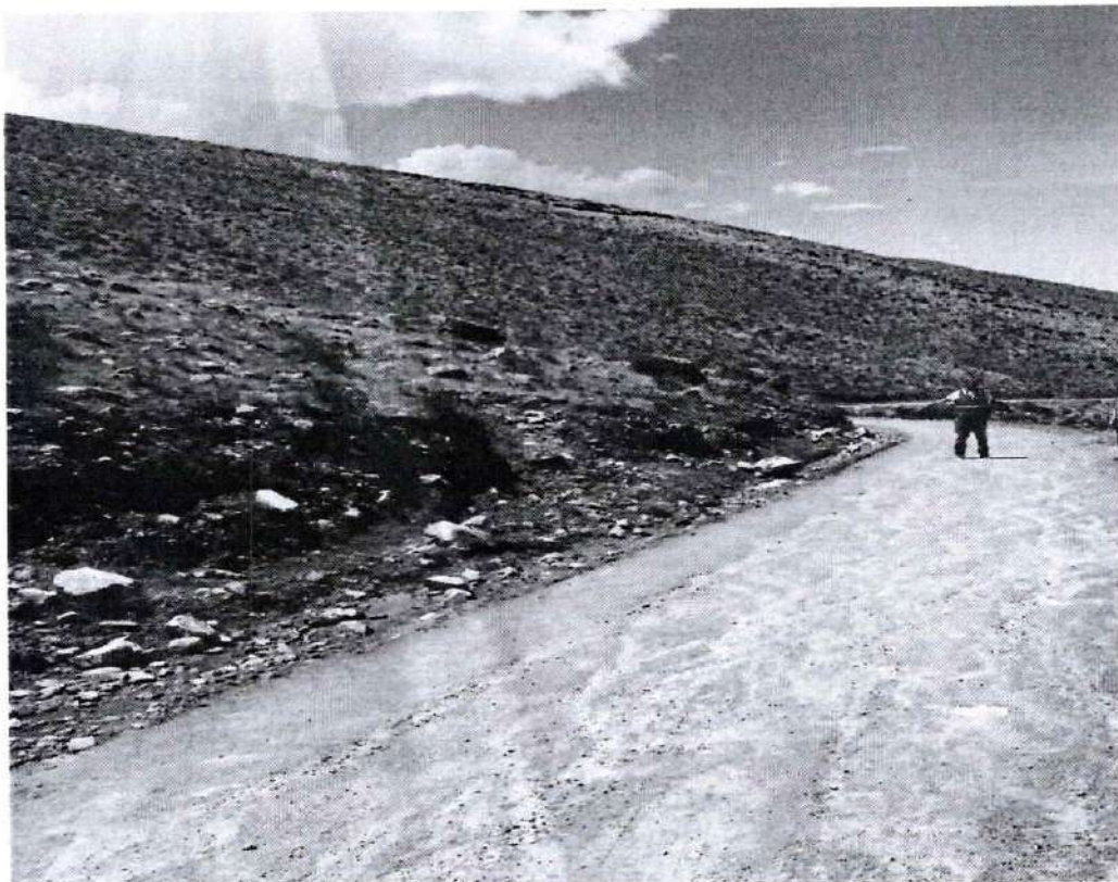
KM. 92+000 CUNETAS COLMATADAS REQUIERE LIMPIEZA DE LOS SEDIMENTOS.
