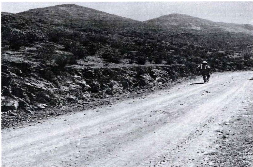
KM. 69+000 SE APRECIA MATERIAL SUELTO EN LA VIA.
