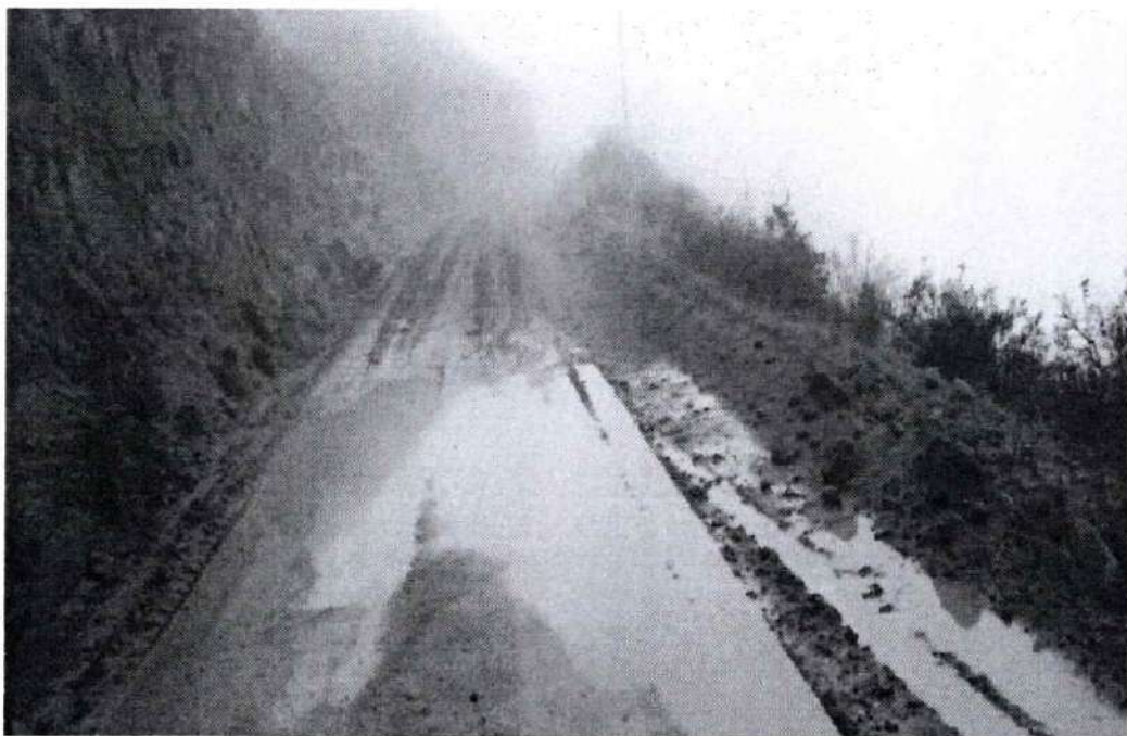
KM. 74+100 SUPERFICIE DE RODADURA CON LODAZAL POR LLUVIAS DE TEMPORADA.
