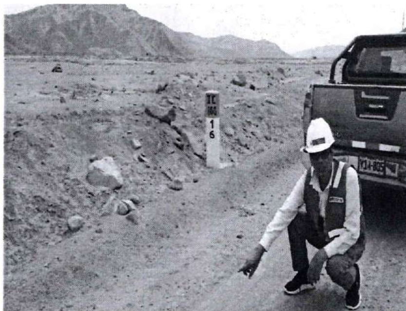
KM. 16+000 MATERIAL SUELTO EN LA SUPERFICIE RODADURA.
