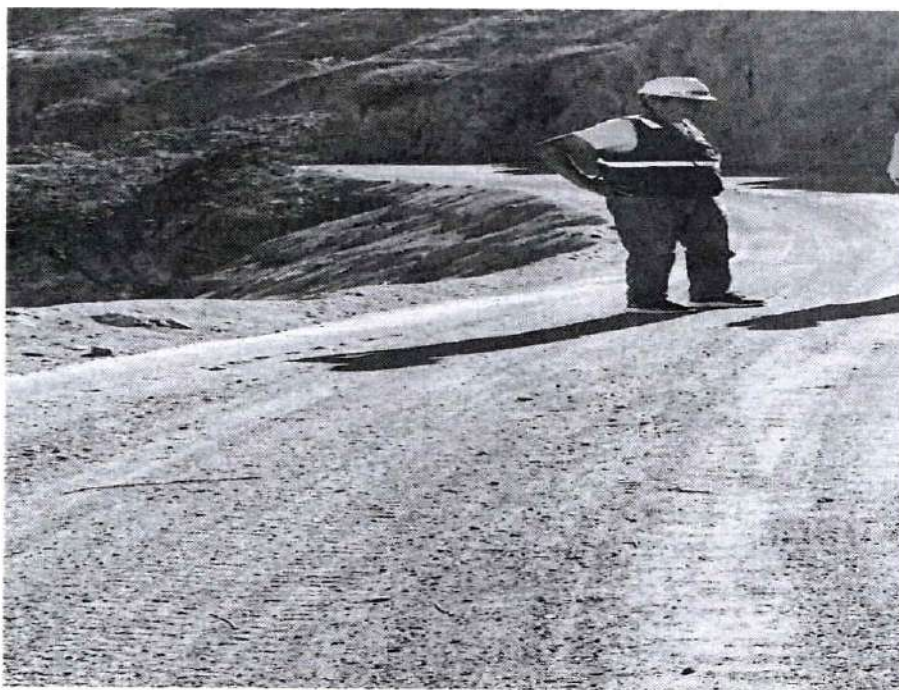
KM.42+600 MATERIAL SUELTO EN LA SUPERFICIE RODADURA.
