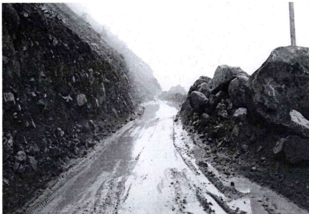
KM. 76+600 SE APRECIA LODAZAL FALTA DE BOMBEO ADECUADO.
