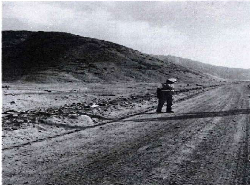
KM. 14+00 VIA ENCALAMINADO REQUIERE MANTENIMIENTO VIAL.
