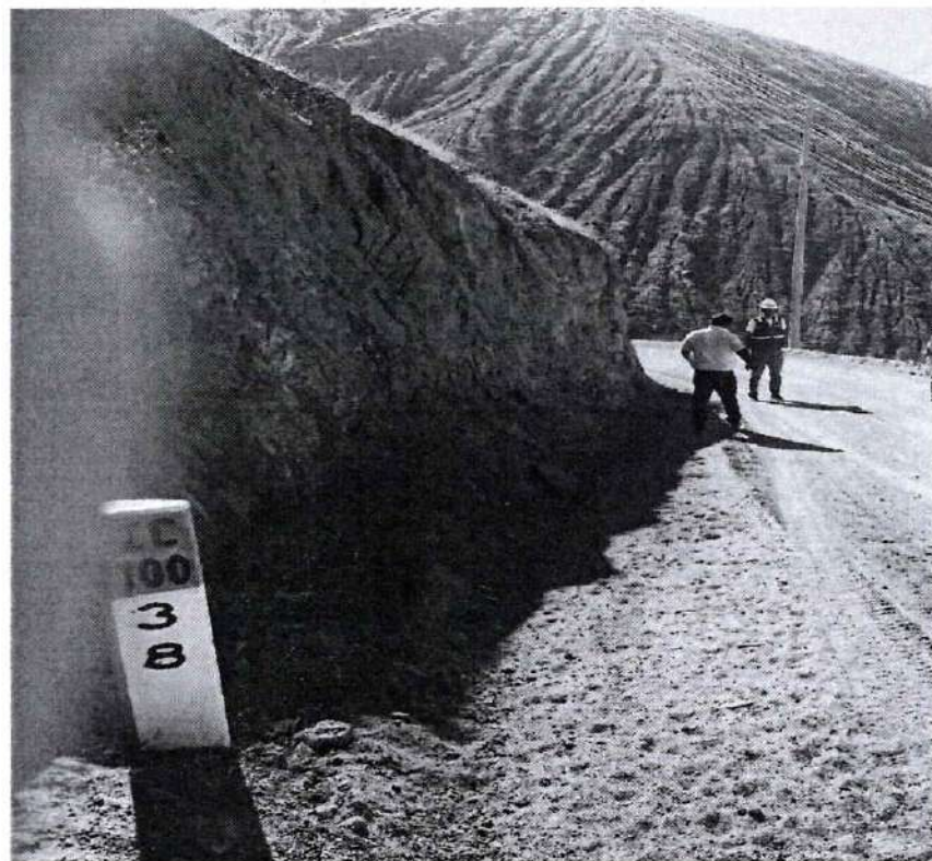
KM.38+000 CUNETAS ENTERRADAS Y SUPERFICIE CON MATERIAL SUELTO.
