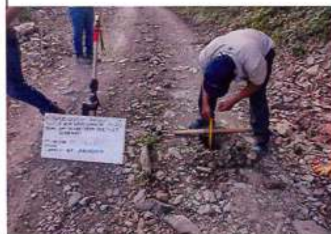
Foto 05: Verificación del espesor existente de afirmado E=
