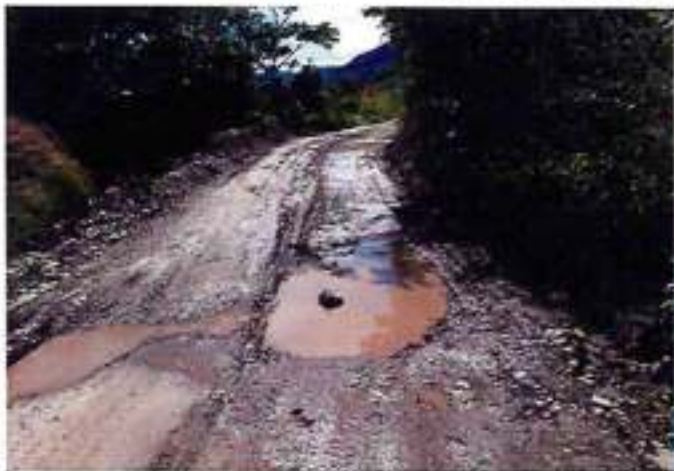
Foto 01: Baches y ahuellamientos
