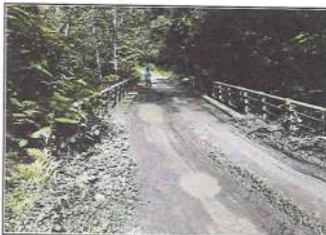
Foto 11: Baches y ahuellamientos
