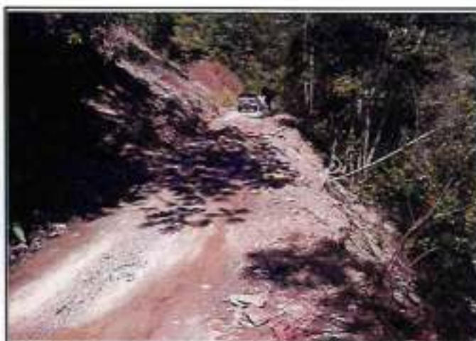
Foto 04: Baches y ahuellamientos
