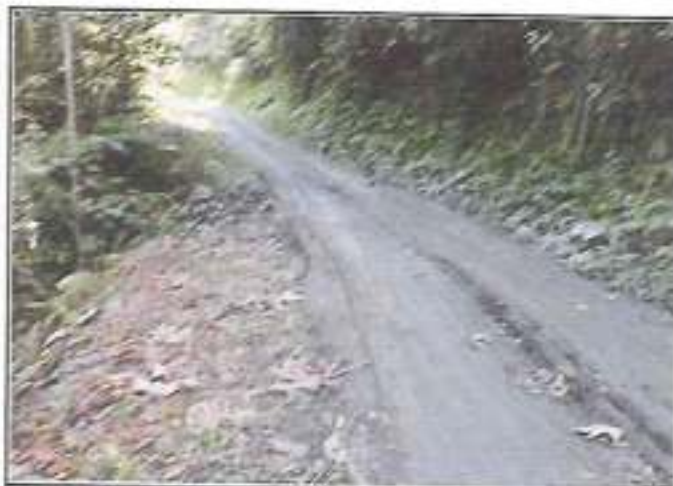
Foto 12: Baches y ahuellamientos
