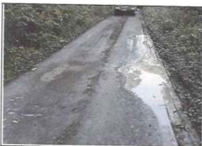
Foto 09: Baches y ahuellamientos
