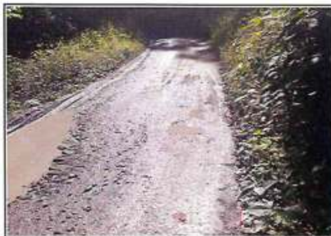
Foto 03: Baches y ahuellamientos
