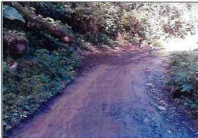
Foto 02: Baches y ahuellamientos
