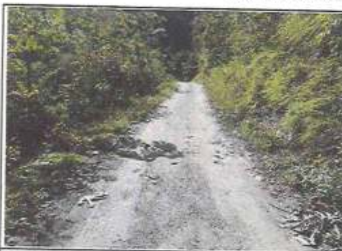
Foto 07: Baches y ahuellamientos
