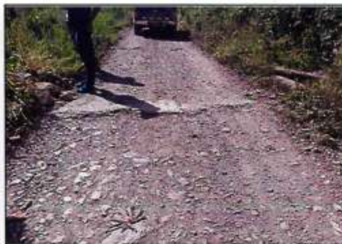
Foto 06: Baches y ahuellamientos
