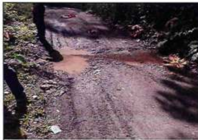
Foto 05: Baches y ahuellamientos
