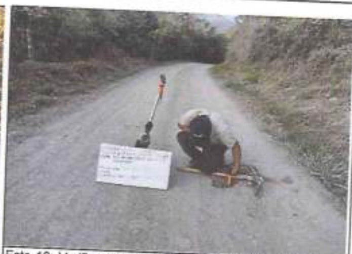
Foto 10: Verificación del espesor existente de afirmado E= 0.03 mts
