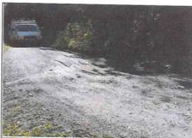
Foto 10: Baches y ahuellamientos
