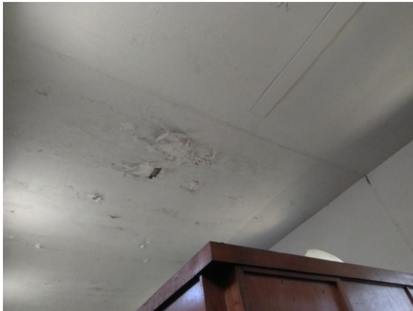
DESPRENDIMIENTO DE TARRAJEO Y PINTURA EN CIELO RASO, NECESITA DE SELLADOR E IMPERMEABILIZACION
