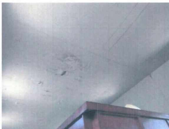
DESPRENDIMIENTO DE TARRAJEO Y PINTURA EN CIELO RASO, NECESITA DE SELLADOR E IMPERMEABILIZACION
