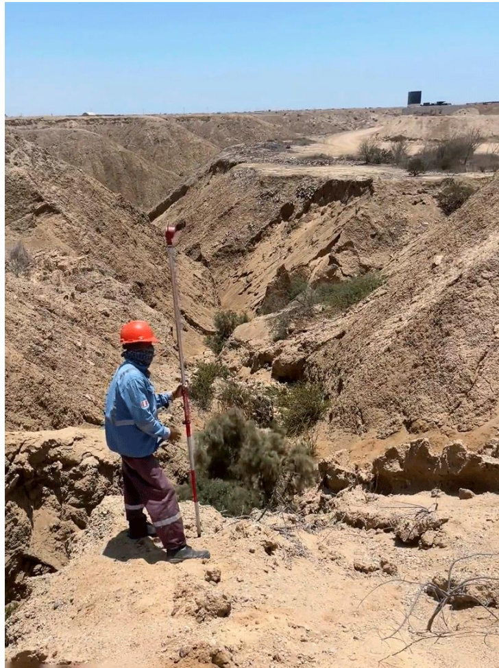
Imagen 2 Toma de puntos en quebrada donde evacuarán las aguas pluviales
