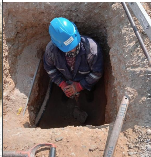
Imagen 7 Calicata BI-1 búsqueda de Interferencias
