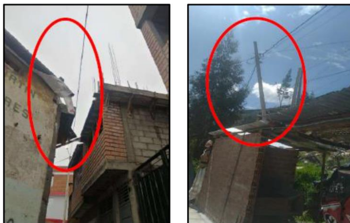
Fig. N° 16 Redes de MT y BT incumpliendo las DMS
