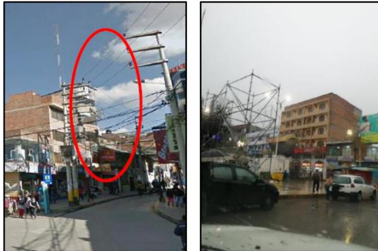
Fig. N° 06: Incumplimiento de las distancias mínimas de seguridad
