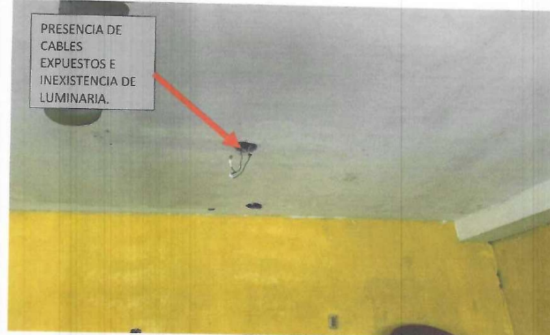
IMAGEN 1. En la presente imagen se observa los cables expuestos, inexistencia de luminaria, y el riesgo que existe al estar expuestos los cables.
