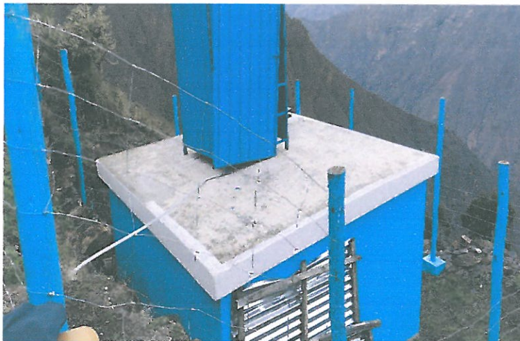
Imagen 19: Caseta de válvulas deterioradas debido a que la válvulas ya no cumple la función de regular adecuadamente
