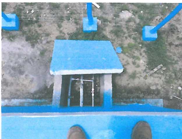
Imagen 21: Vista de la caseta de válvulas con llaves deterioradas
