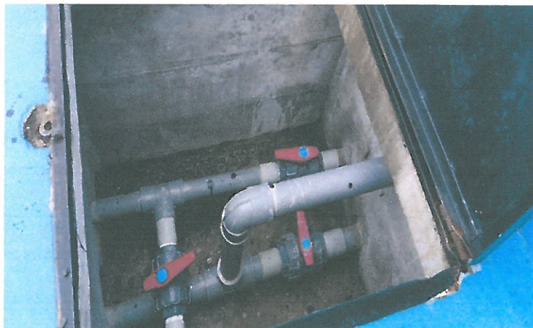
Imagen 19: Caseta de válvulas deterioradas debido a que la válvulas ya no cumple la función de regular adecuadamente
