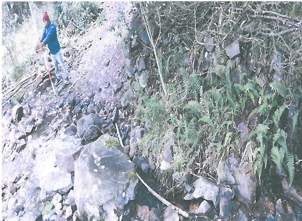
Imagen 15: Tubería expuestas en la línea de conducción progresiva 4+930 km
