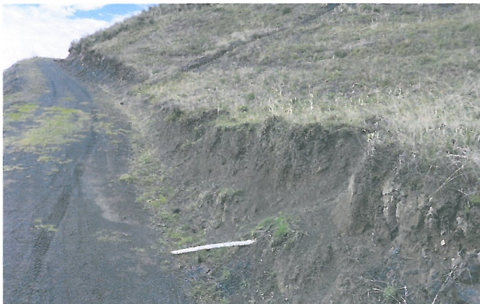
Imagen 15: Tubería expuestas en la línea de conducción progresiva 4+930 km
