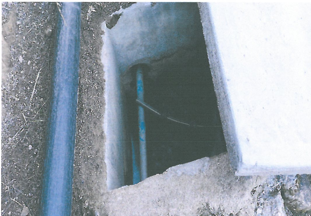
Imagen 17: Se observa la cámara rompe presión sin accesorios adecuados con acumulación de lodos y tapas oxidadas
