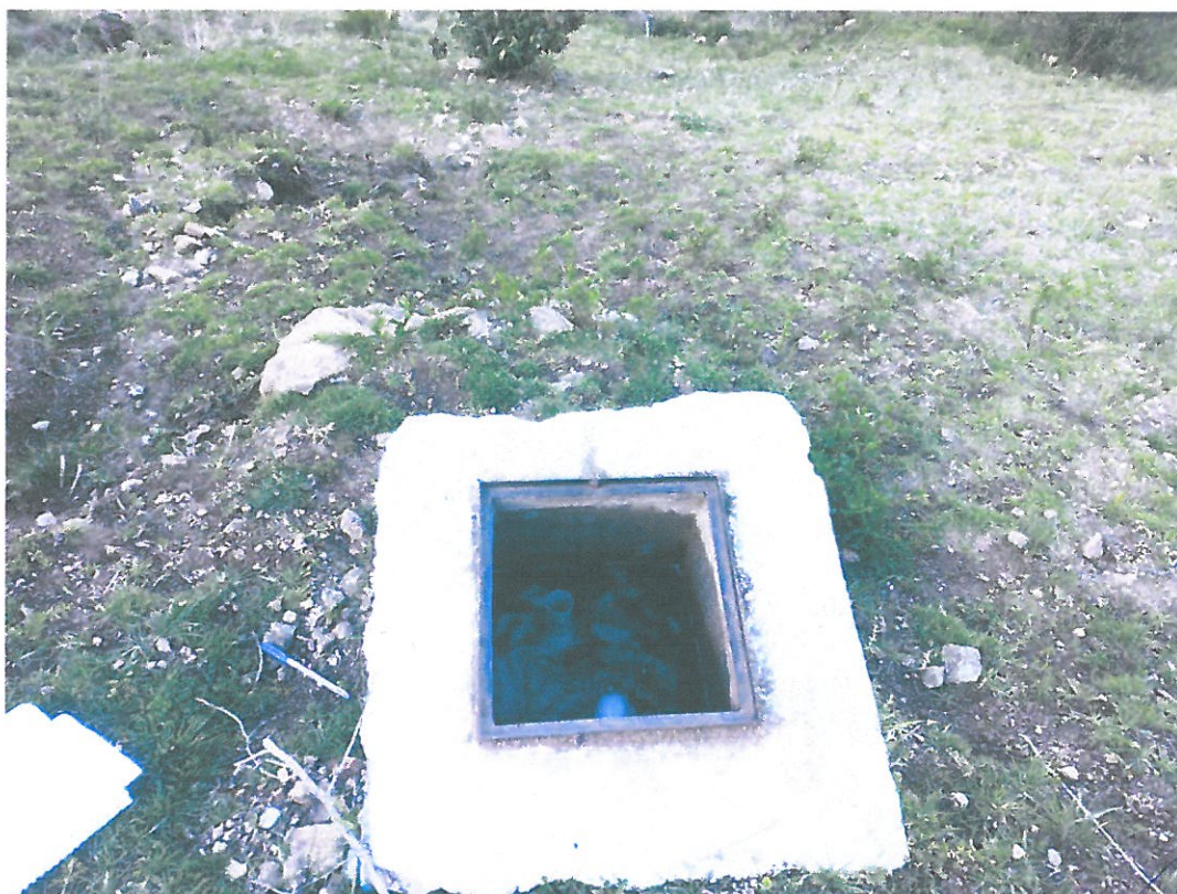
Imagen 17: Se observa la cámara rompe presión sin accesorios adecuados con acumulación de lodos y tapas oxidadas
