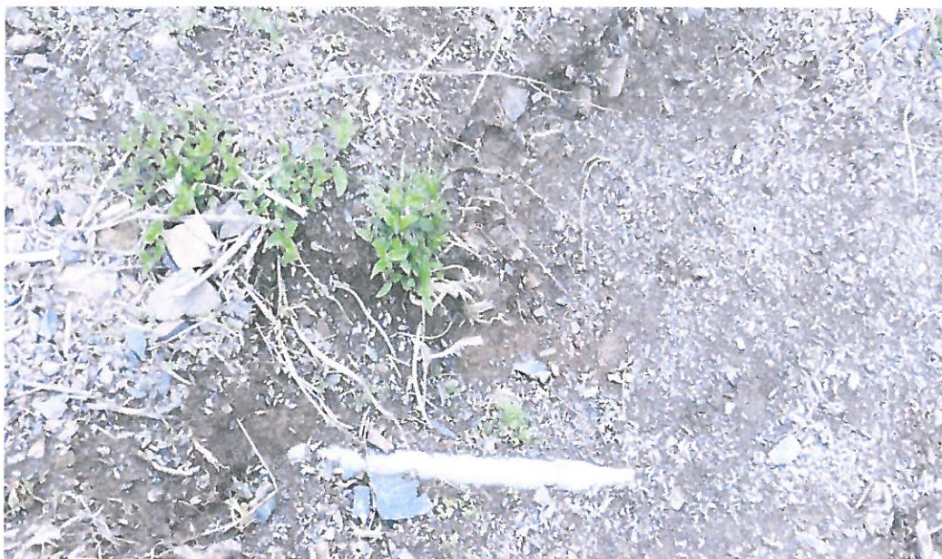
Imagen 22: Vista de las tuberías expuestas en la línea de conducción de la comunidad de Chamana
