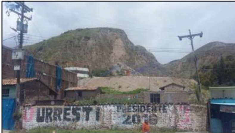
Fig. N° 04: Postes de madera de media tensión deteriorados
