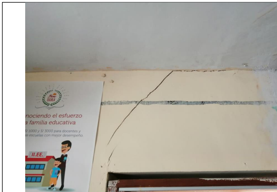
Fotografía N°05: Se visualiza rajaduras y fisuras en la paredes internas de bloques de adobe
