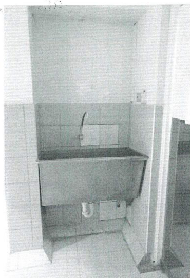
Fotografía N° 07: Retiro de lavatorio de acero inoxidable de una poza en Centro Quirúrgico para luego enchapar de cerámica la pared.
