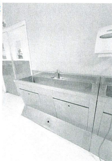
Fotografía N° 06: cambio de grifería y pedal de pie para los lavatorios de acero inoxidable existente en Centro Quirúrgico debido a que se necesita mayor altura de grifería.
