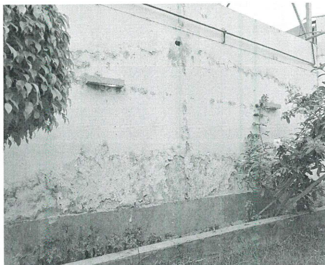
Fotografía N° 11 Presencia de humedad y salitre en muros, por lo que se requiere el resane total.
