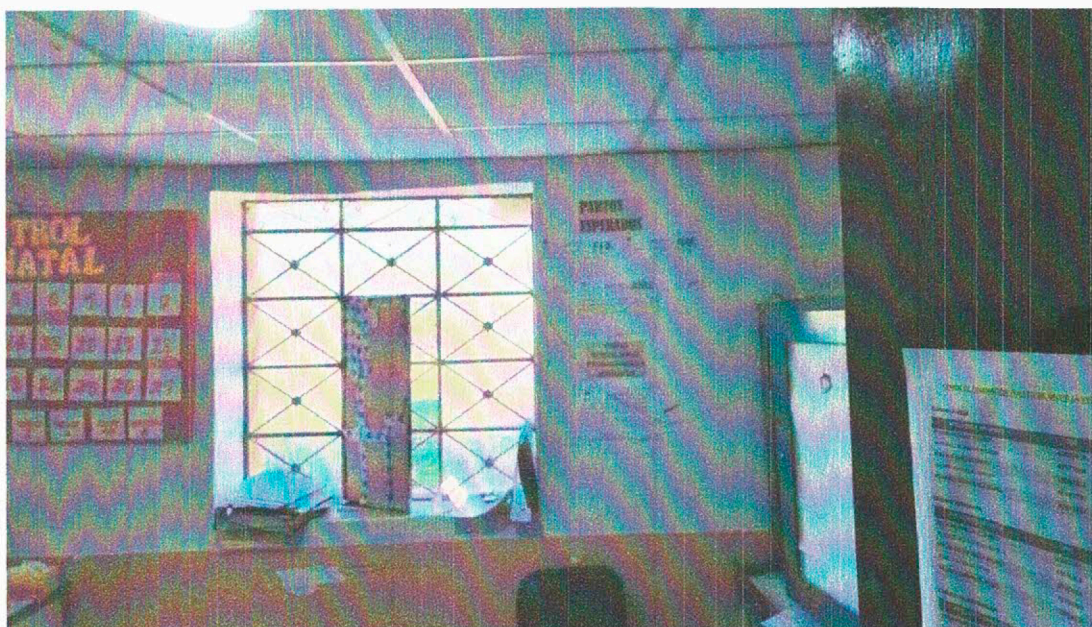
Foto 13. Se observa vidrios de la ventana en mal estado
