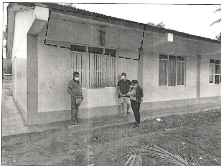
FOTOGRAFIA N° 02: SE OBSERVA EN LA IMAGEN LAS FILTRACIONES DE AGUA QUE DEJARON HUELLAS EN LA PARED.
