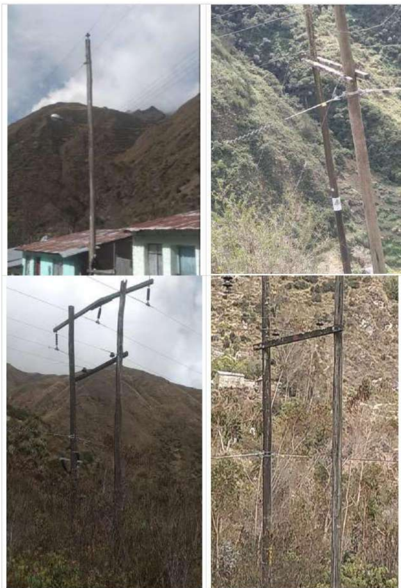
Estructuras en el AMT A4506, requieren su mejoramiento, por haber cumplido su vida útil o incumplimiento de DMS
