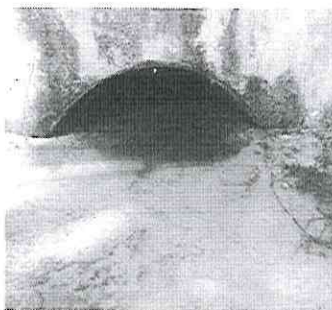
Carretera Iquitos - Nauta; Limpieza de Alcantarillas (colmatación con arena y exceso de vegetación)
