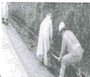
Materiales varios amontonados en la cuneta (maleza, estancamiento de aguas fluviales). Carretera Iquitos – Nauta limpieza de cunetas de mortero
