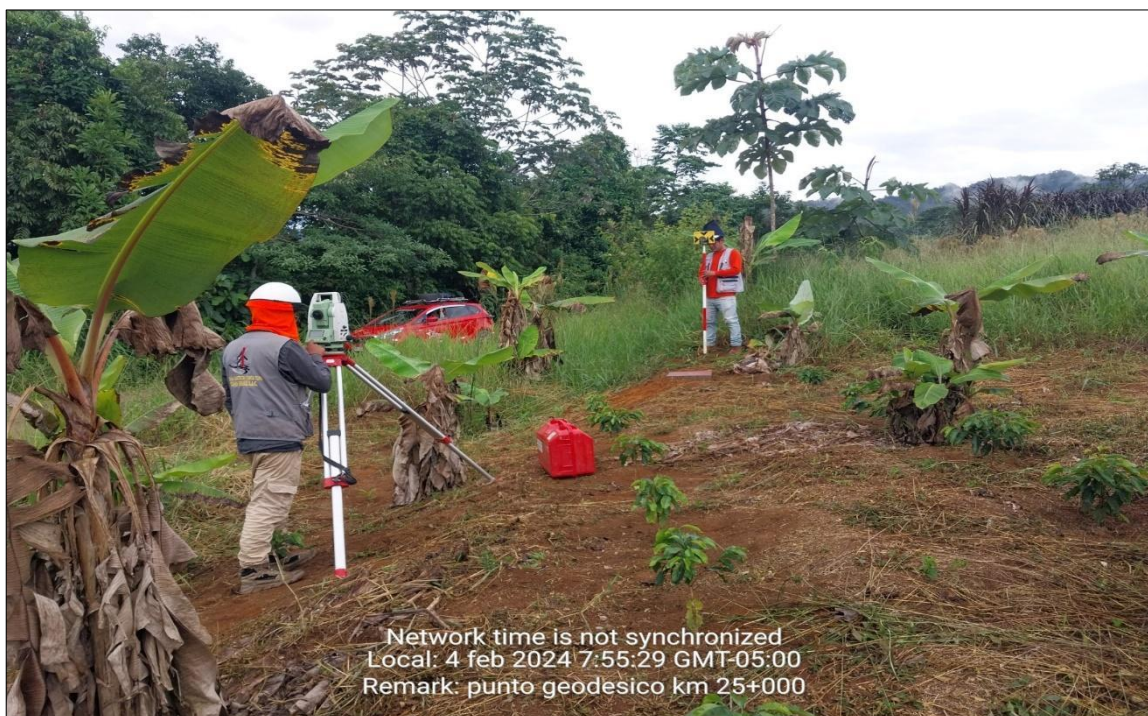
Orientación a mis BMs con la estación total T06S
