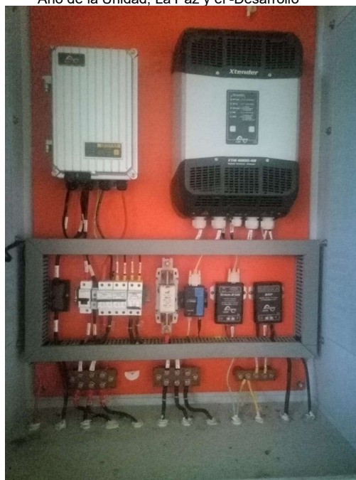
Fig. N° 06 TABLERO DE CONTROL
