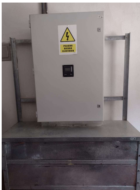
Fig. N° 11 RACK DE BATERIAS
