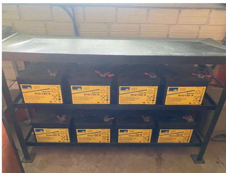
Fig. N° 09 RACK DE BATERIAS A SER REEMPLAZADO
