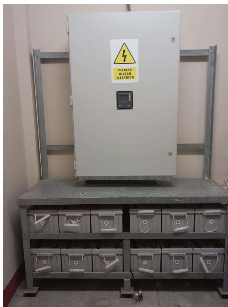
Fig. N° 07 RACK DE BATERIAS
