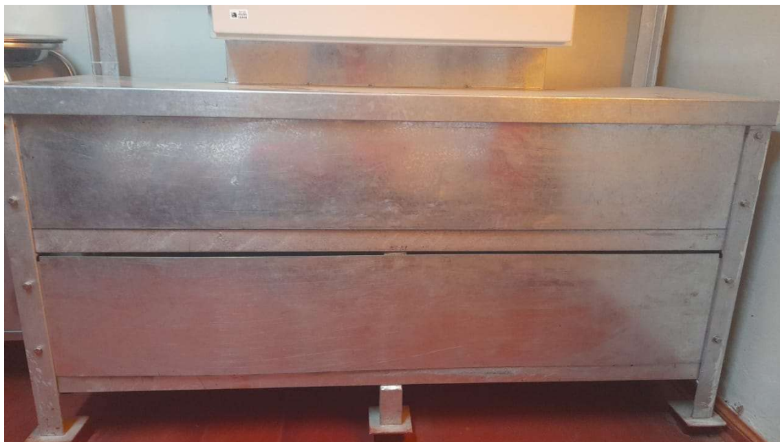
Fig. N° 04 RACK DE BATERIAS
