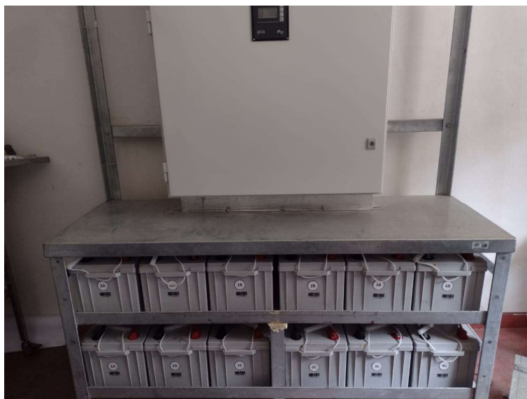
Fig. N° 13 RACK DE BATERIAS
