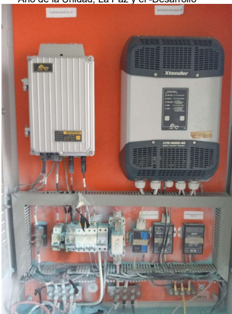
Fig. N° 12 TABLERO DE CONTROL PARA CAMBIO DE EQUIPOS
