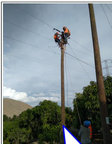
Figura N° 05 Poste de media tensión deteriorados, incumpliendo DMS
