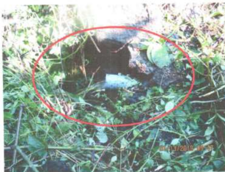
La vegetación y musgos ha ocasionado la erosión y fracturamiento del concreto.
