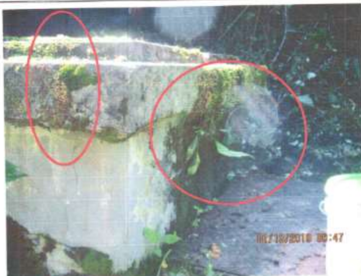
La vegetación y musgos ha ocasionado la erosión y fracturamiento del concreto.
