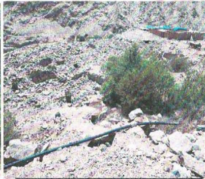
Tramos de tubería de PVC expuesta a lo largo de la línea de conducción
