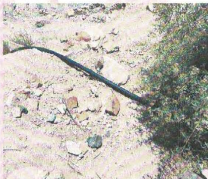
Tubería de PVC expuesta y doblada sin accesorios a lo largo de la línea de conducción
