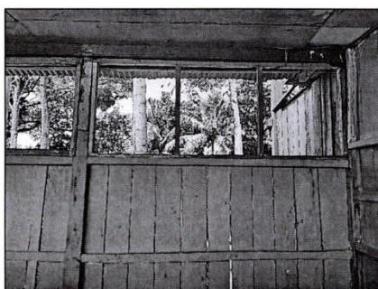
FOTO N° 06: Se visualizan las ventanas de una de las aulas de madera, las cuales se encuentran en mal estado, sin vidrio que impida el ingreso de polvo al interior del ambiente.
