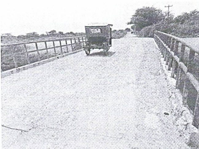
Foto 08: Puente 01 / Prog 2+600 .Se aprecia el desgaste de la losa con exposición del acero , el cual compromete a la losa, vigas y sardinel de borde.
