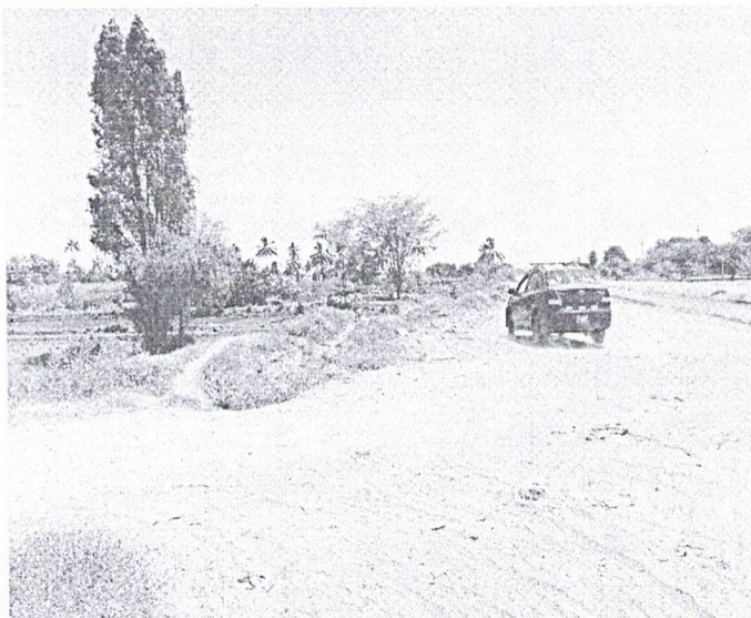
Foto N° 02: Se observa la carencia de obras de arte a lo largo del camino, en esta prog. 0+070 se ha proyectado la instalación de una alcantarilla TMC Ø 24"
