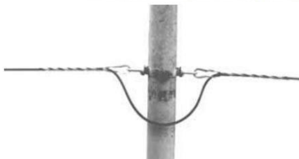
Ferretería de suspensión para inicio, fin y cambio de dirección
