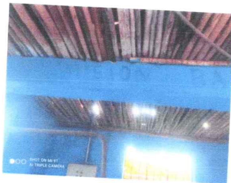
Imagen N°07: techo de carrizo Caseta de Pozo tubular "El motor "
