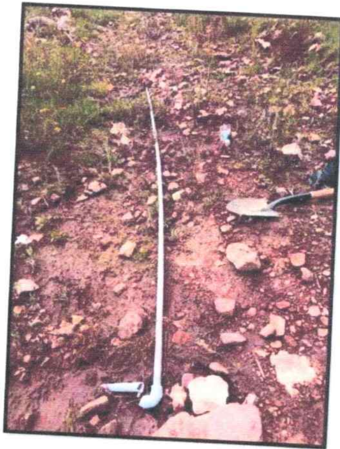
Imagen N°16: Tuberías expuestas en red de distribución.
