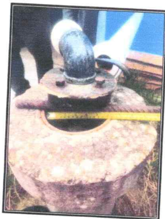
Imagen N°11: diametro DE TUBERIA DE ADEME 6" Pozo tubular "El
