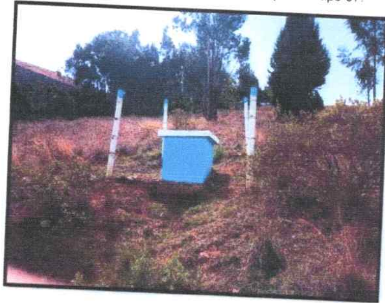
Imagen N°17: Cámara Rompe presión tipo 07.
