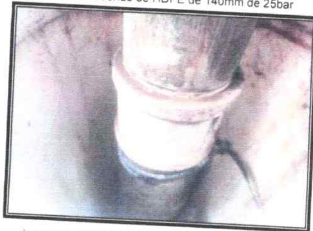
Imagen N°13: tubería de fierro galvanizado de 2"
