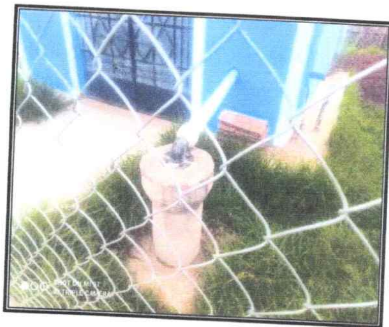
Imagen N°10: Pozo tubular expuesto al intemperismo
