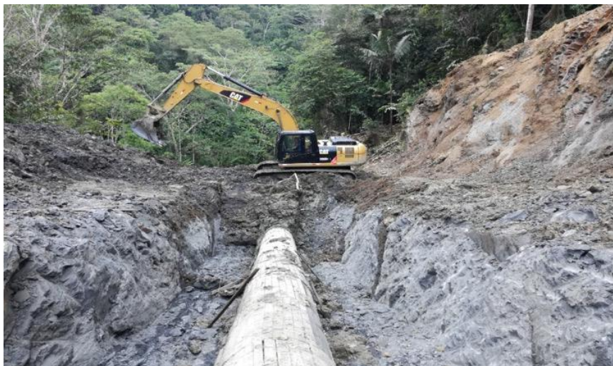
Gráfico 6 Excavación con maquinaria de tubería ONP.
