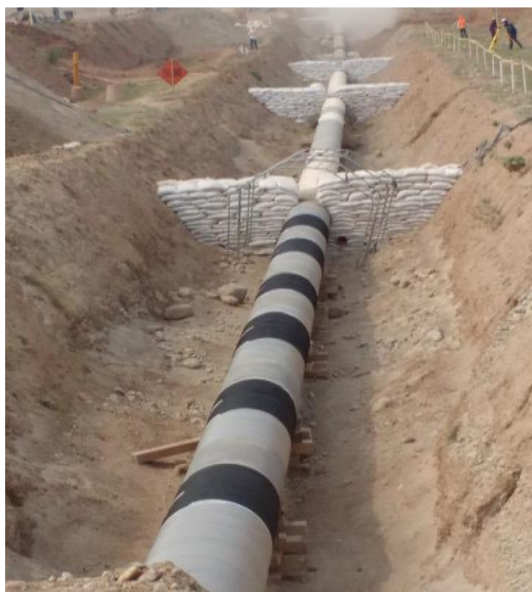
Gráfico 10 Anillo de protección terminado.
