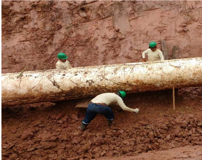
Gráfico N° 2.: Excavación manual, para liberar la tubería
