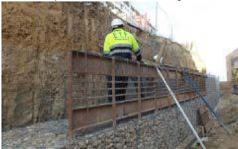
Esquema del encofrado exterior del gavión
