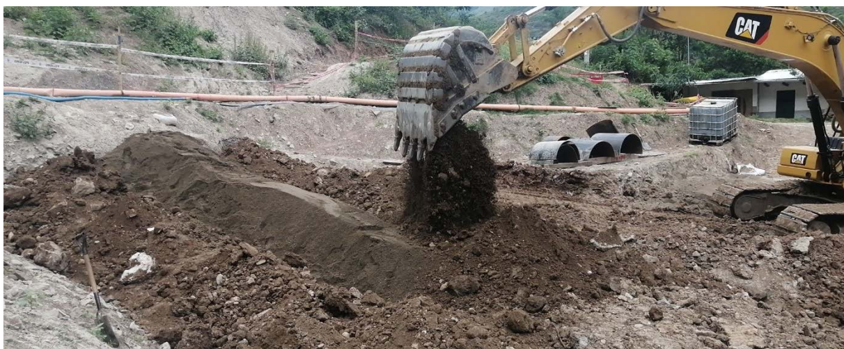
Gráfico N° 11. Relleno de zanja con material propio y equipo mecánico
