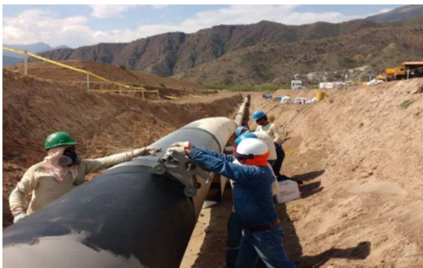
Gráfico N° 7 – Colocación de Polyguard
