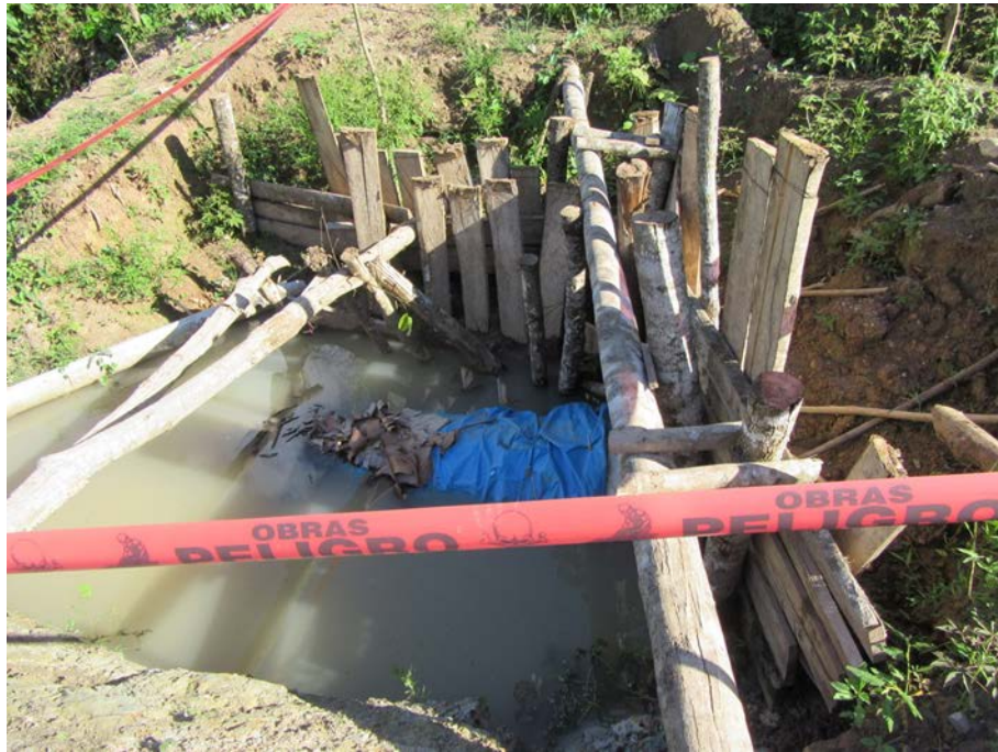
Gráfico N° 4.- Entibado de zanja actual en zona de tubería descubierta – Km 400+710
