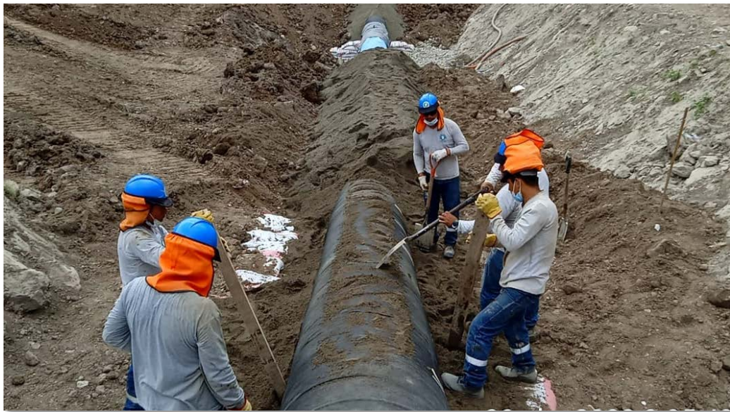
Gráfico N° 12. Relleno de zanja con material seleccionado y apisonado
