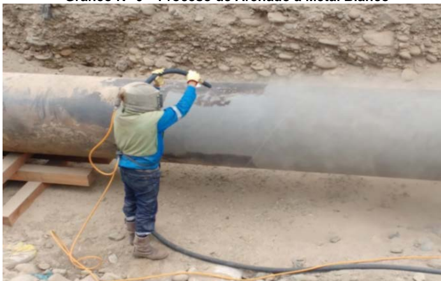
Gráfico N° 6 – Proceso de Arenado a Metal Blanco
