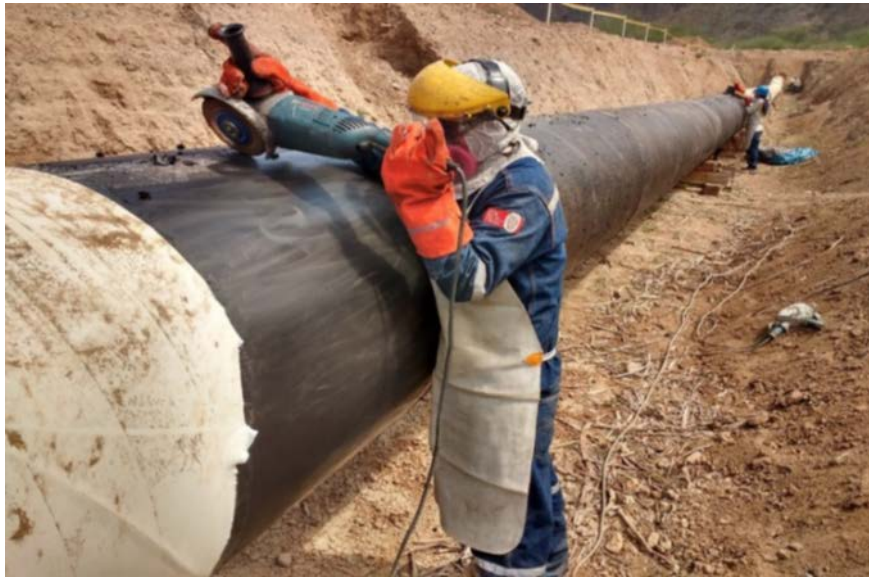
Gráfico N° 8 – Limpieza mecánica con amoladora, del ONP
