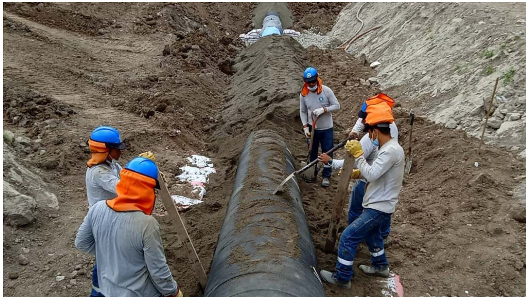
Gráfico N° 10. Relleno de zanja con material seleccionado y apisonado
