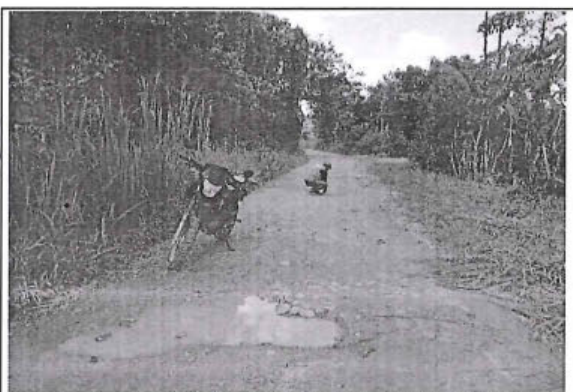
Foto 115: El tramo evaluado desde la prog. 36+550 a la prog. 36+687, presenta daños en la calzada de tipo Baches, encontrándose 12, de nivel de gravedad: 2.
