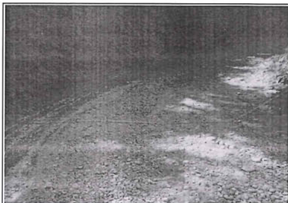
Foto 92: El tramo evaluado desde la prog. 27+100 a la prog. 27+350, presenta daños en la calzada de tipo Erosión, de nivel de gravedad: 3, alcanzando 4.20 m. de ancho de deterioro.
