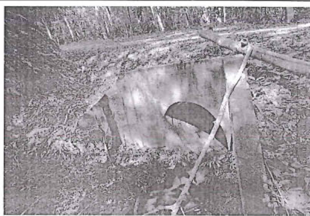
Foto 40: Alcantarilla TMC en buen estado de conservación y buena condición funcional. Prog. 29+858 del C.V. HU-556.
