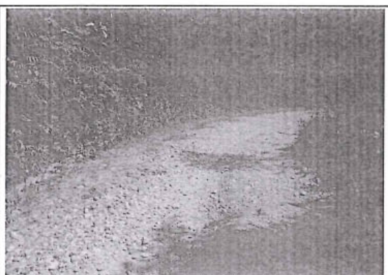
Foto 95: El tramo evaluado desde la prog. 28+430 a la prog. 28+500, presenta daños en la calzada de tipo Erosión, de nivel de gravedad: 3, alcanzando 3.70 m. de ancho de deterioro.
