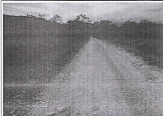
Foto 104: El tramo evaluado desde la prog. 31+820 a la prog. 31+980, presenta daños en la calzada de tipo Deformación, de nivel de gravedad: 3, alcanzando 3.40 m. de ancho de deterioro.
