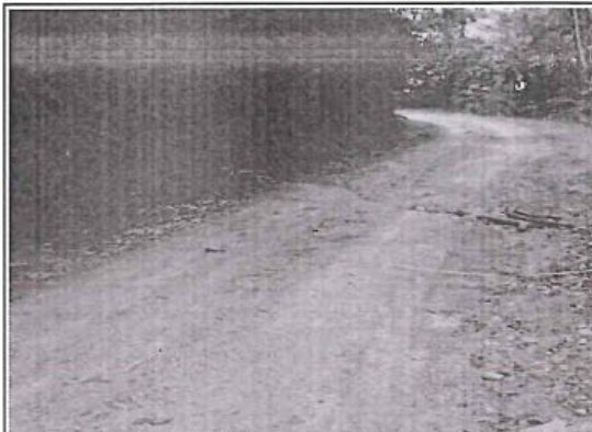
Foto 106: El tramo evaluado desde la prog. 32+420 a la prog. 32+500, presenta daños en la calzada de tipo Erosión, de nivel de gravedad: 3, alcanzando 1.60 m. de ancho de deterioro.
