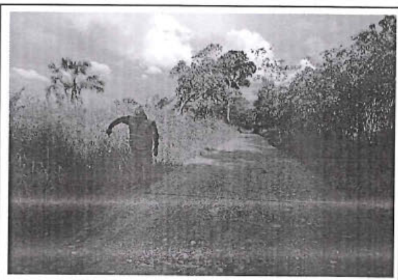
Foto 86: El tramo evaluado desde la prog. 25+200 a la prog. 25+265, presenta daños en la calzada de tipo Baches, encontrándose 7, de nivel de gravedad: 3.
