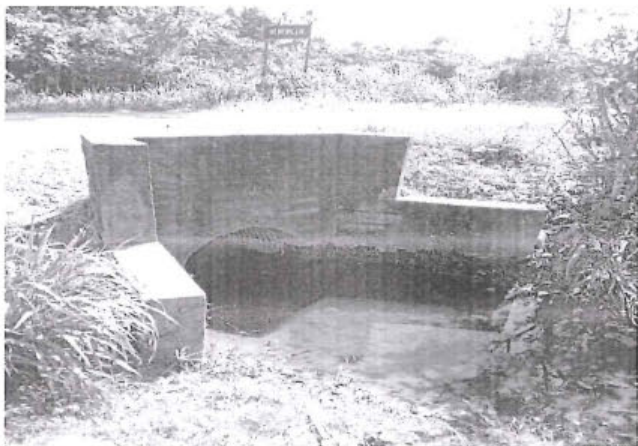
Foto 73: Alcantarilla TMC en buen estado de conservación y buena condición funcional. Prog. 35+877 del C.V. HU-556.
