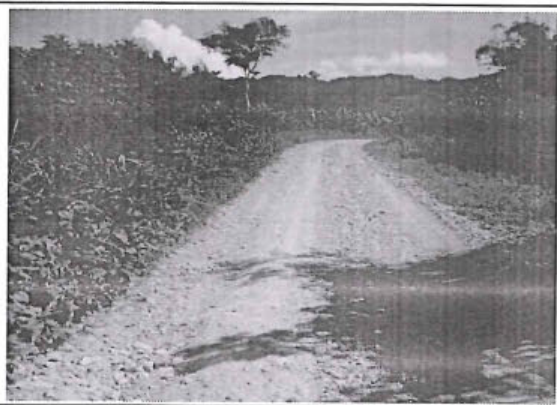
Foto 85: El tramo evaluado desde la prog. 25+000 a la prog. 25+200, presenta daños en la calzada de tipo Deformación, de nivel de gravedad: 3, alcanzando 2.10 m. de ancho de deterioro.
