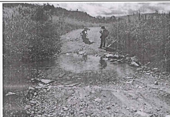
Foto 103: El tramo evaluado desde la prog. 31+734 a la prog. 31+820, presenta daños en la calzada de tipo Cruce de Agua, afectando todo el ancho de la vía (3.7 m.)
