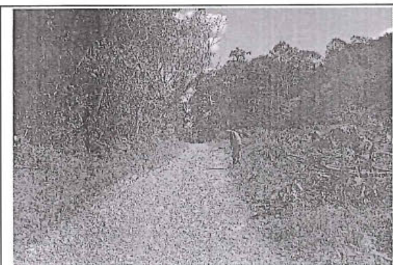
Foto 107: El tramo evaluado desde la prog. 32+620 a la prog. 33+000, presenta daños en la calzada de tipo Erosión, de nivel de gravedad: 3, alcanzando 1.60 m. de ancho de deterioro.
