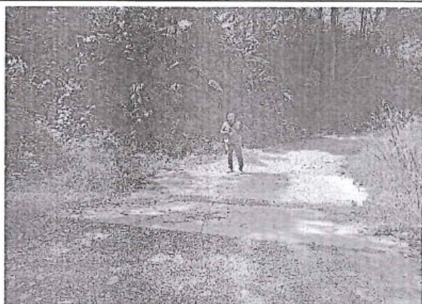
Foto 65: Badén en buen estado de conservación y de buena funcionalidad. Prog. 33+990 del C.V. HU-556
