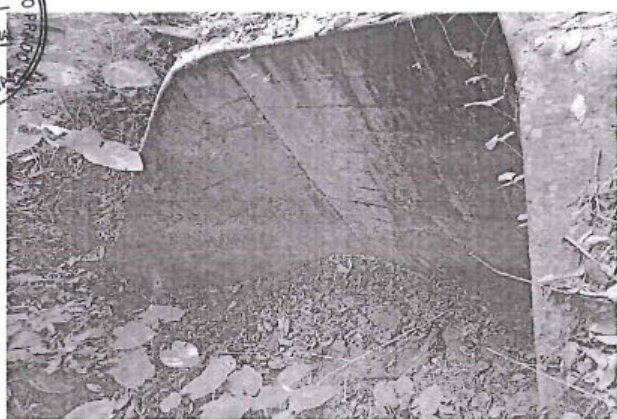
Foto 69: Alcantarilla TMC en buen estado de conservación y buena condición funcional. Prog. 34+908 del C.V. HU-556.
