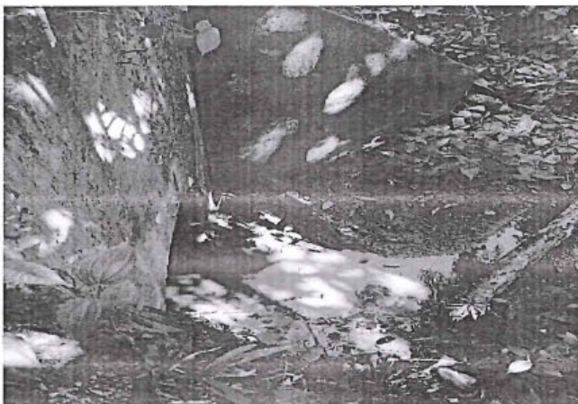
Foto 67: Alcantarilla TMC en buen estado de conservación y buena condición funcional. Prog. 34+444 del C.V. HU-556.
