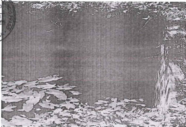
Foto 63: Alcantarilla TMC en buen estado de conservación y buena condición funcional. Prog. 33+690 del C.V. HU-556.
