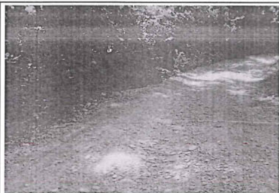
Foto 93: El tramo evaluado desde la prog. 27+500 a la prog. 28+000, presenta daños en la calzada de tipo Deformación, de nivel de gravedad: 3, alcanzando 4.10 m. de ancho de deterioro.
