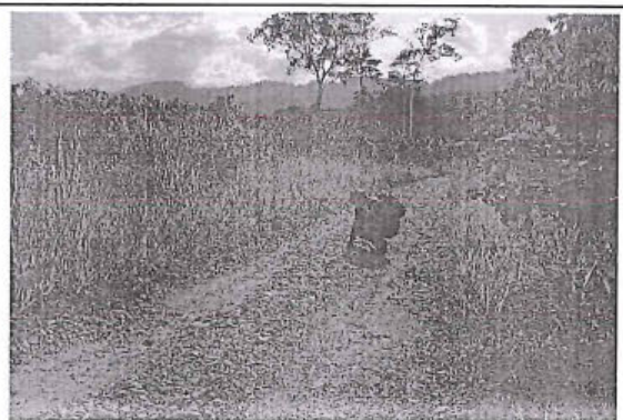
Foto 82: El tramo evaluado desde la prog. 24+395 a la prog. 24+410, presenta daños en la calzada de tipo Deformación, de nivel de gravedad: 3, alcanzando 3.00 m. de ancho de deterioro.
