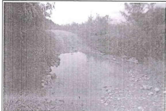
Foto 102: El tramo evaluado desde la prog. 31+460 a la prog. 31+734, presenta daños en la calzada de tipo Cruce de Agua, afectando todo el ancho de la vía (4.0 m.)
