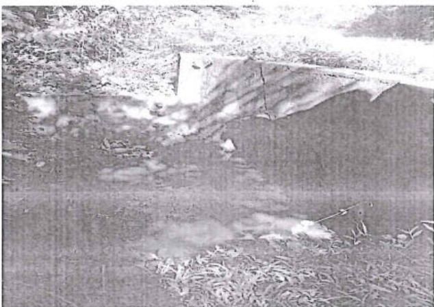
Foto 71: Alcantarilla TMC en buen estado de conservación y buena condición funcional. Prog. 35+129 del C.V. HU-556.
