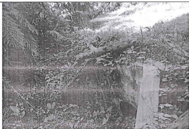
Foto 49: Alcantarilla TMC en buen estado de conservación y buena condición funcional. Prog. 32+070 del C.V. HU-556.
