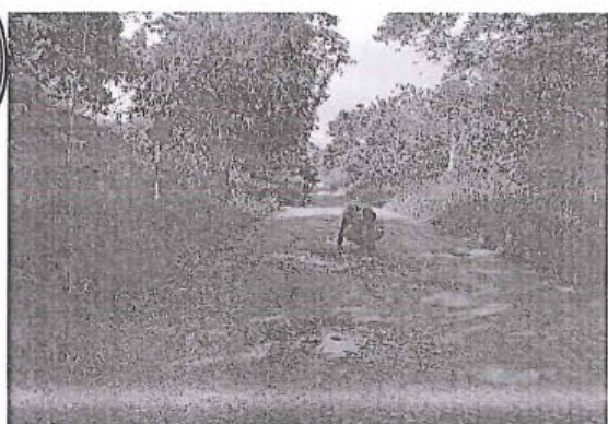
Foto 81: El tramo evaluado desde la prog. 24+285 a la prog. 24+360, presenta daños en la calzada de tipo Baches, encontrándose 4, de nivel de gravedad: 1.
