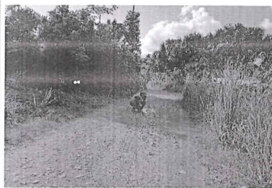
Foto 80: El tramo evaluado desde la prog. 24+170 a la prog. 24+210, presenta daños en la calzada de tipo Cruce de Agua, afectando todo el ancho de la vía (4.3 m.)
