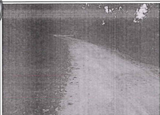
Foto 105: El tramo evaluado desde la prog. 32+100 a la prog. 32+256, presenta daños en la calzada de tipo Baches, encontrándose 8, de nivel de gravedad: 2.
