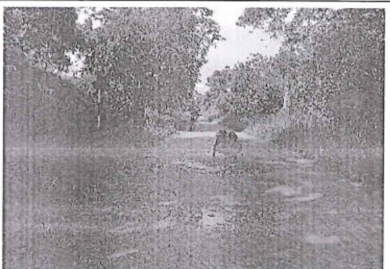
Foto 84: El tramo evaluado desde la prog. 24+810 a la prog. 24+822, presenta daños en la calzada de tipo Baches, encontrándose 1, de nivel de gravedad: 1.
