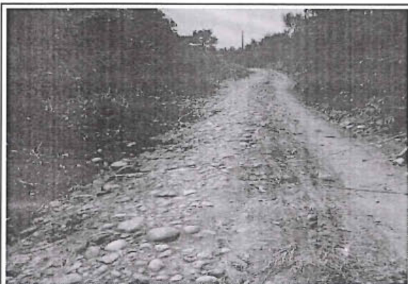
Foto 91: El tramo evaluado desde la prog. 26+500 a la prog. 27+000, presenta daños en la calzada de tipo Erosión, de nivel de gravedad: 3, alcanzando 3.80 m. de ancho de deterioro.
