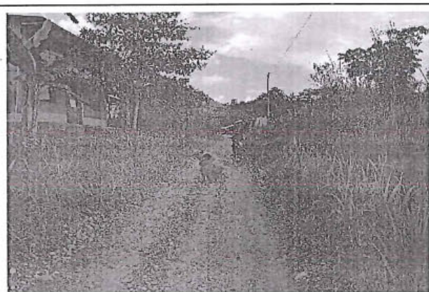
Foto 16: Superficie de rodadura de afirmado en la prog. 26+500 del C.V. HU-556, con esatdo de transitabilidad regular.
