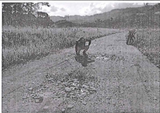
Foto 79: El tramo evaluado desde la prog. 24+070 a la prog. 24+169, presenta daños en la calzada de tipo Baches, encontrándose 7, de nivel de gravedad: 2.
