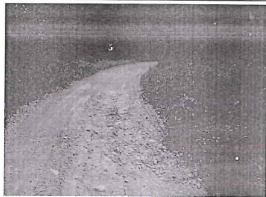
Foto 87: El tramo evaluado desde la prog. 25+500 a la prog. 25+835, presenta daños en la calzada de tipo Erosión, de nivel de gravedad: 2, alcanzando 1.30 m. de ancho de deterioro.
