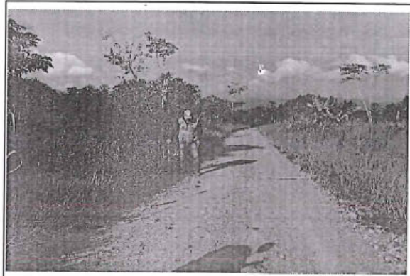
Foto 88: El tramo evaluado desde la prog. 25+975 a la prog. 25+990, presenta daños en la calzada de tipo Erosión, de nivel de gravedad: 2, alcanzando 1.00 m. de ancho de deterioro.
