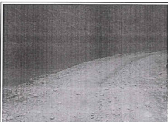
Foto 109: El tramo evaluado desde la prog. 33+840 a la prog. 34+000, presenta daños en la calzada de tipo Erosión, de nivel de gravedad: 3, alcanzando 3.80 m. de ancho de deterioro.
