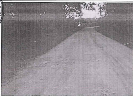
Foto 111: El tramo evaluado desde la prog. 34+500 a la prog. 34+734, presenta daños en la calzada de tipo Baches, encontrándose 11, de nivel de gravedad: 1.
