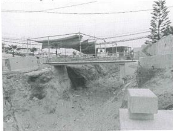
Aguas abajo del Puente N° 1, nótese la sección reducida y la curva posterior
