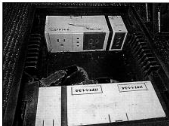
Imagen 1: Tomacorrientes empotrados en piso.
