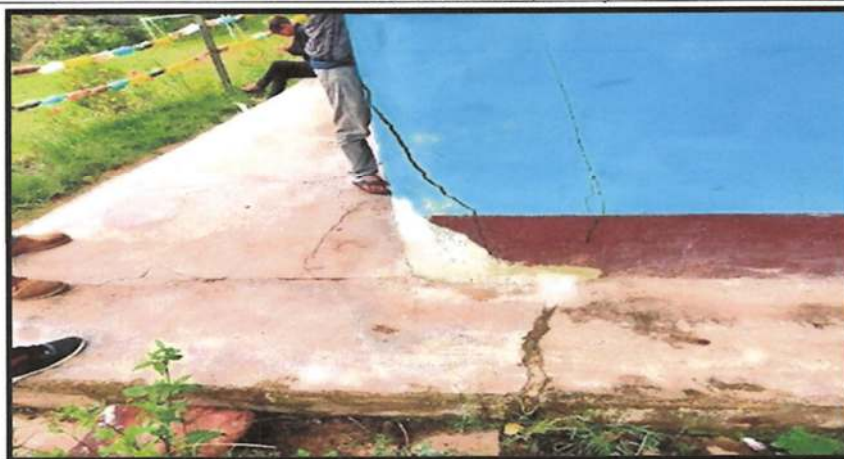
Foto: 02 Vista de pared exterior fallada.
