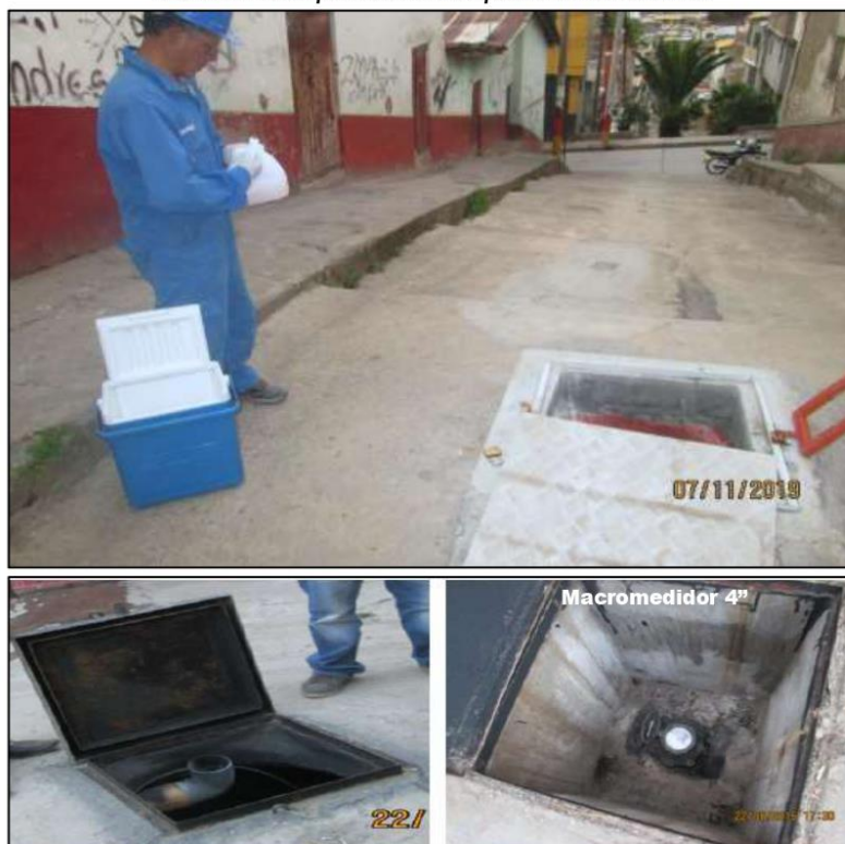
Ilustración 7: Componentes de la captación Plaza de Armas
