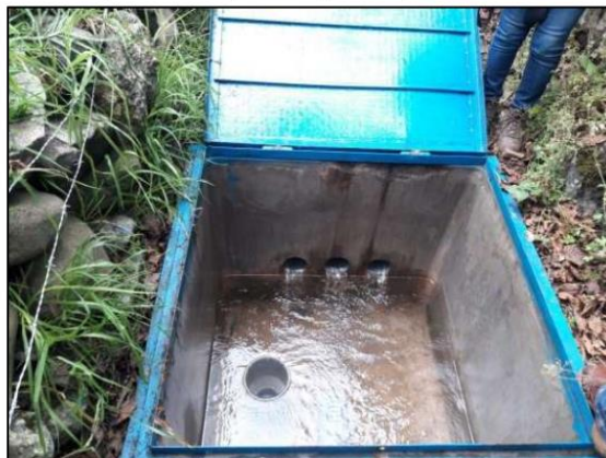
Ilustración 27: Captación Huasipara – Caja de inspección.
