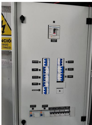
Figura: Tablero general eléctrico ubicada en el primer piso
