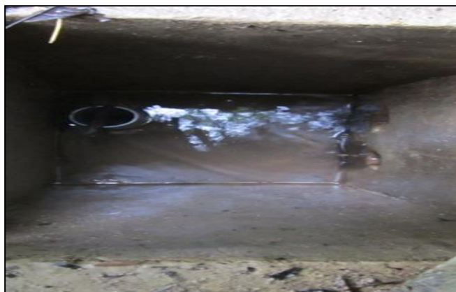
Captación existente en estado deplorable
