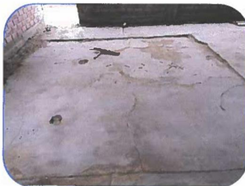
Fotografía N° 06.- Estado actual del piso existente, presenta fisuras y desniveles.
