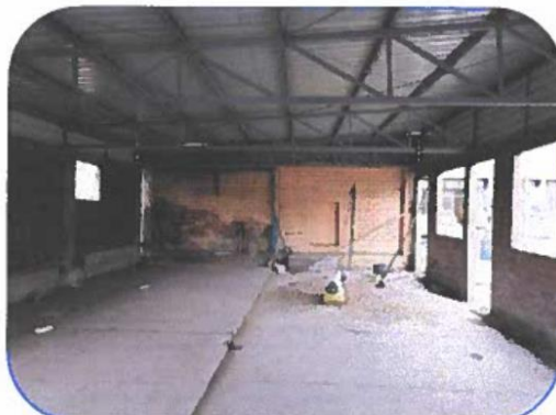
Fotografía N°04.- Vista interna 01 del Laboratorio de Construcción Civil, presenta cobertura liviana de tr4 con tijerales metálicos.
