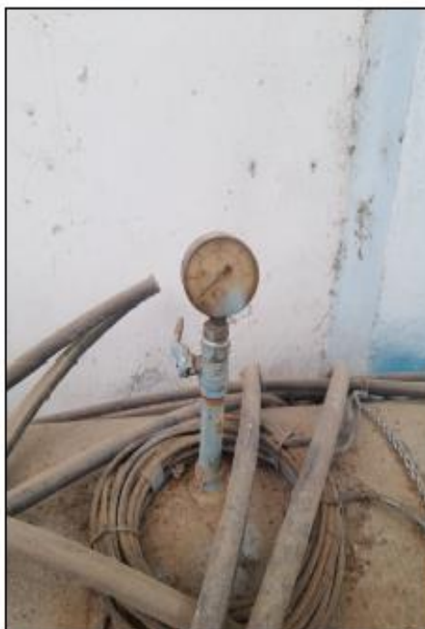
Manómetro inoperativo que necesita ser reemplazado.
