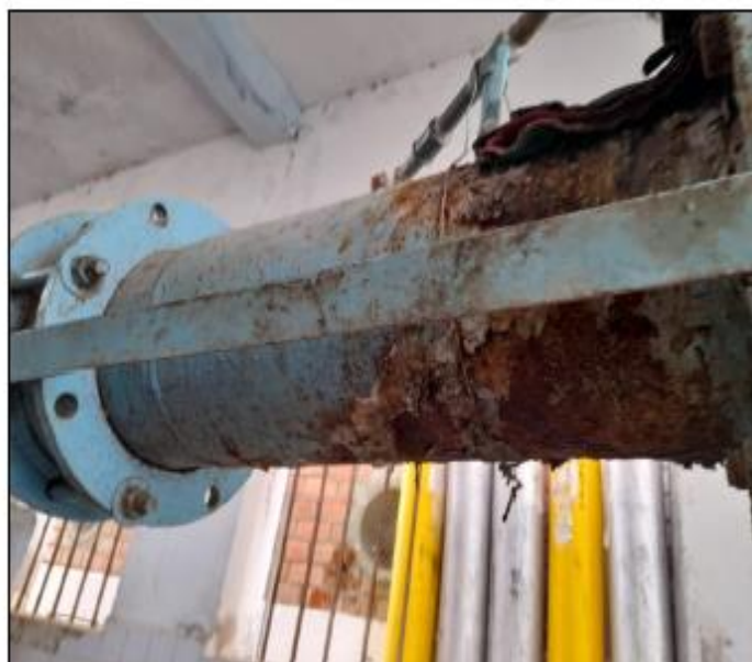
Árbol hidráulico en mal estado.
