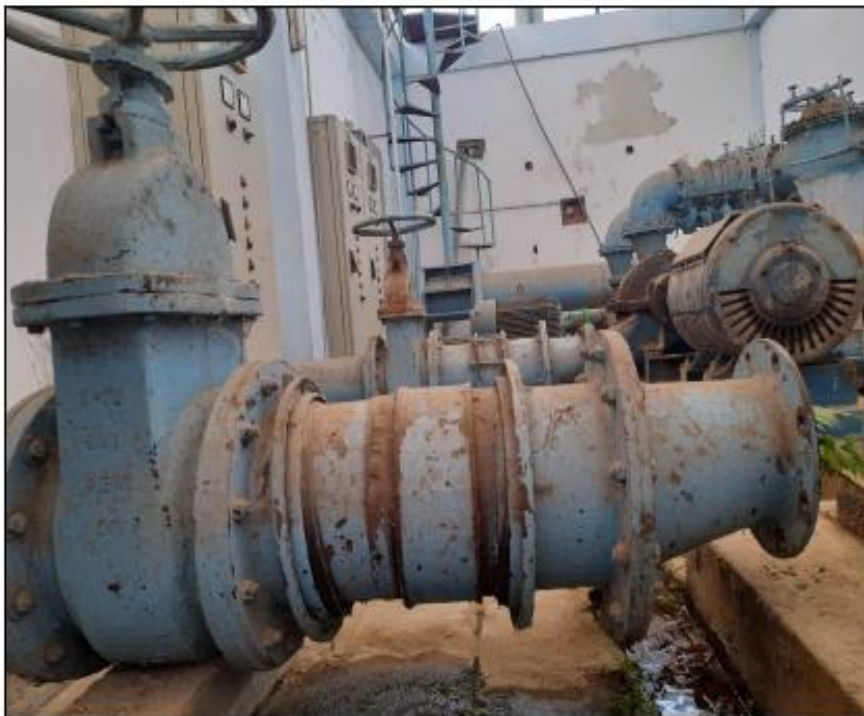
Tramo del árbol hidráulico que se encuentra fuera de servicio por falta de equipo de bombeo.
