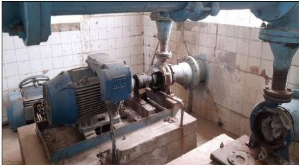
Tramo del árbol hidráulico que se encuentra fuera de servicio por falta de equipo de bombeo.
