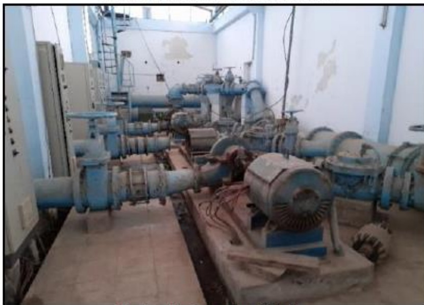
Equipos de Bombeo en Estación Tumbes.
