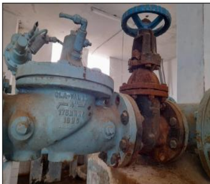
Válvula compuerta de 4 pulgadas en mal estado.
