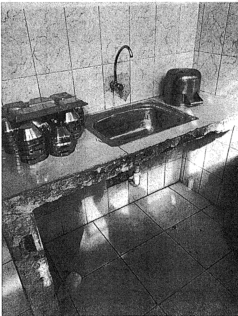
Registro fotográfico 8: Falta de mantenimiento en los lavaderos de concreto
