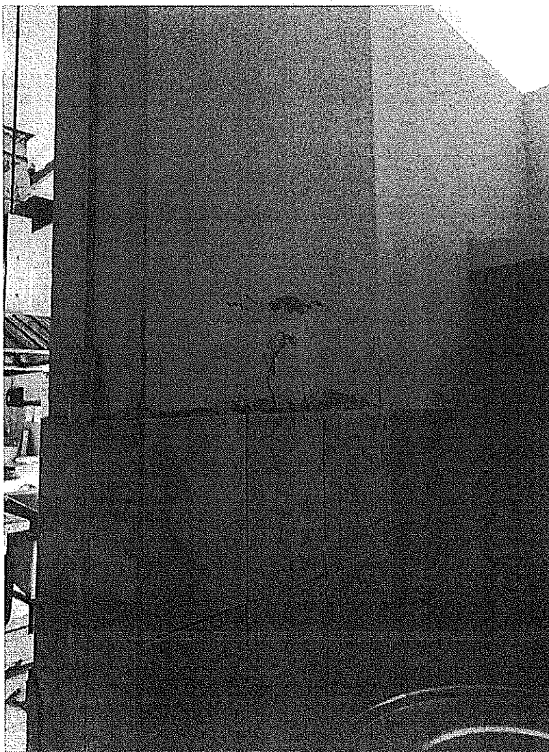
Registro fotográfico 9: Presencia de humedad en la pintura de las columnas
