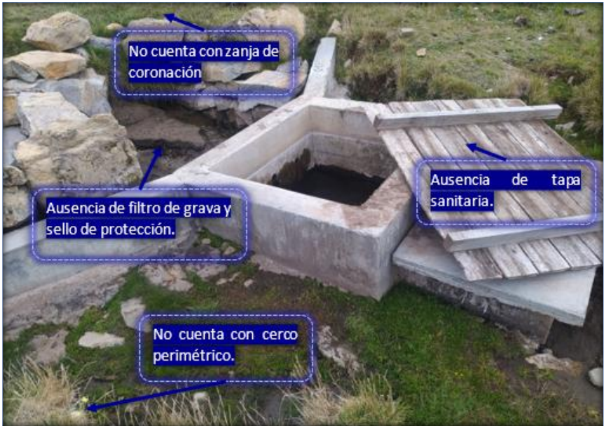
Imagen N° 16 Captación tipo ladera N° 01 "WACHAO PUQUIO"
