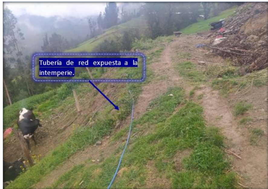
Imagen N° 73 Line de distribución expuesta sin recubrimiento de material no recomendada.
