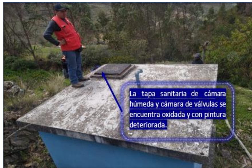
Imagen N° 52 Reservorio N°02 y su caja de válvulas de la localidad de Villa la Libertad
