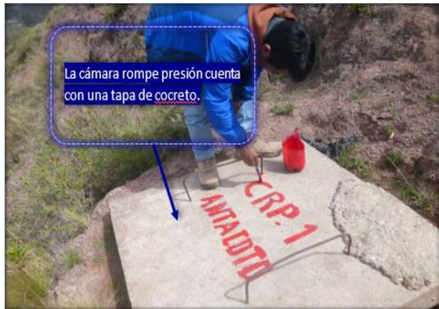
Imagen N° 67 Cámara rompe presión de la localidad de Antacoto
