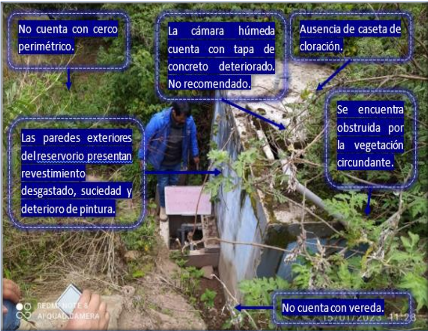
Imagen N° 71 Reservorio N°02 y su respectiva caja de válvulas de la localidad de Antacoto
