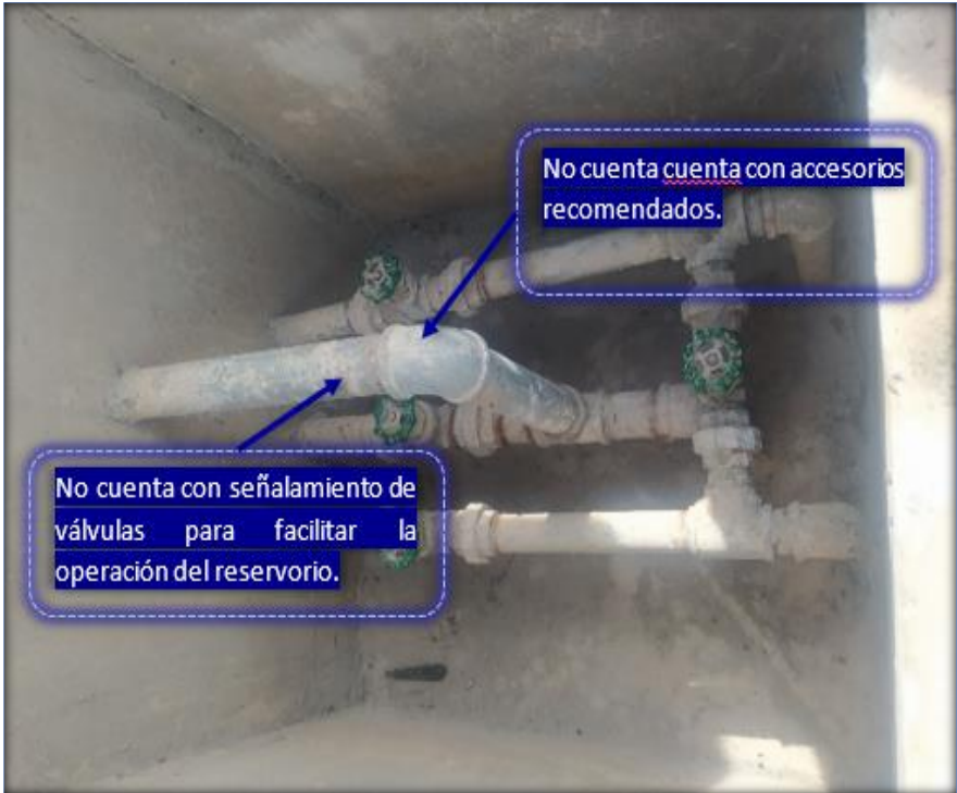
Imagen N° 59 Caja de válvulas del reservorio N° 01 de la localidad de San Cristóbal Fuente: Elaboración propia – Equipo Técnico
