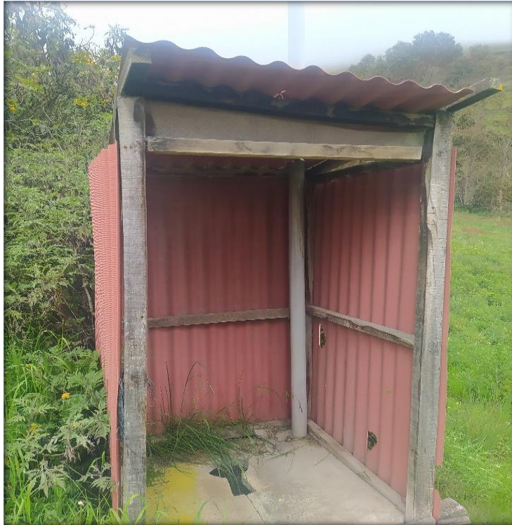
Imagen N° 82 Sistema de excretas colapsado - San Cristóbal
