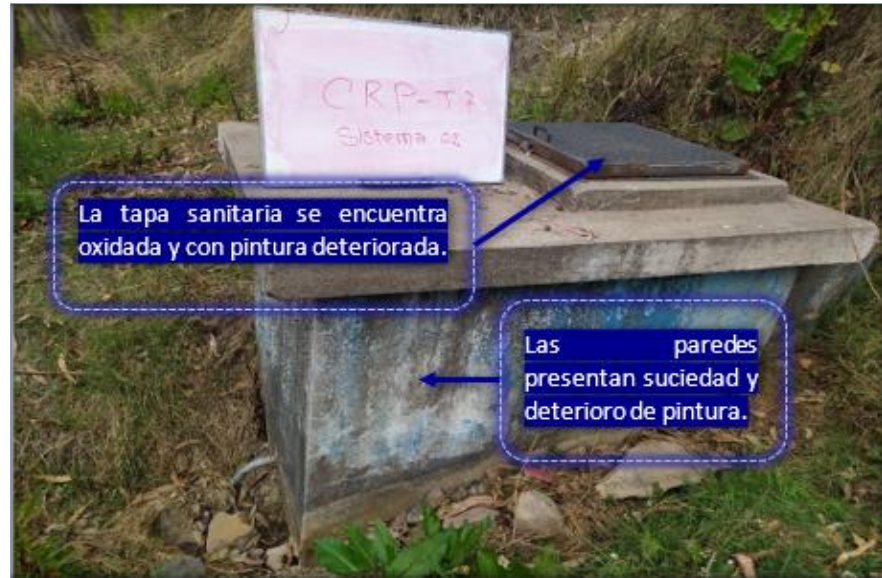
Imagen N° 47 Cámara rompe presión de la localidad de Villa la Libertad
