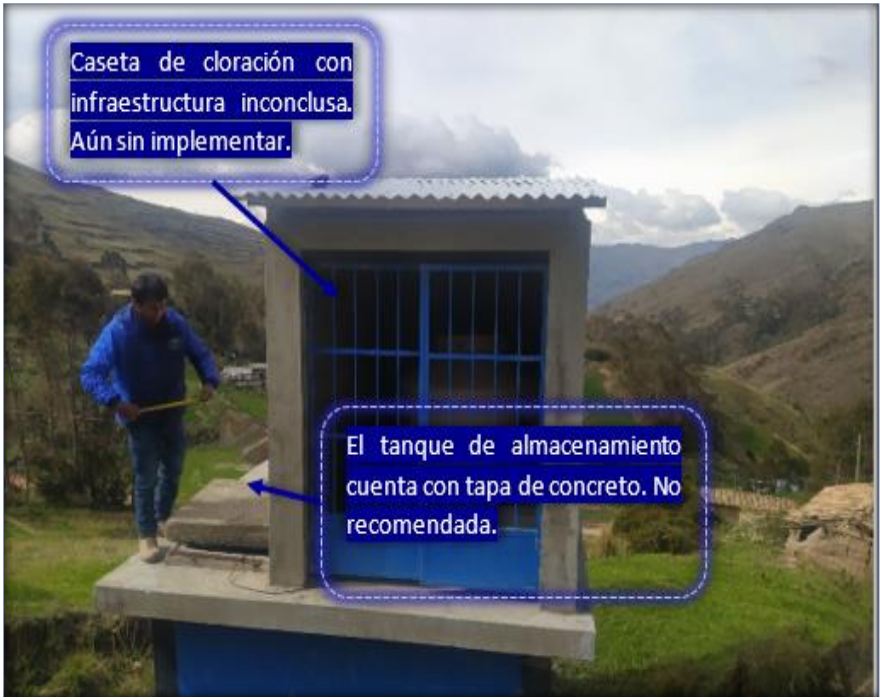
Imagen N° 58 Caseta de cloración del Reservoirio N° 01 de la localidad de San Cristóbal Fuente: Elaboración propia – Equipo Técnico
