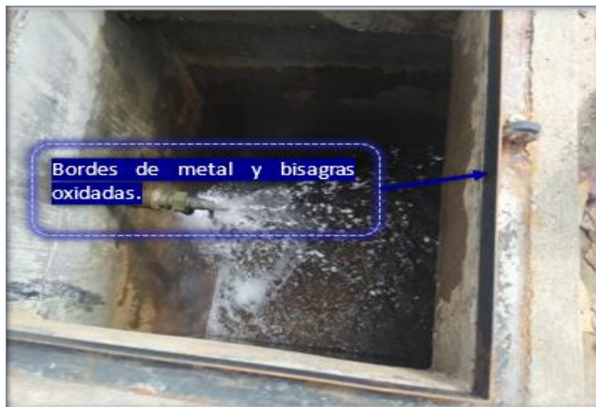
Imagen N° 48 Cámara rompe presión de la localidad de Villa la Libertad
