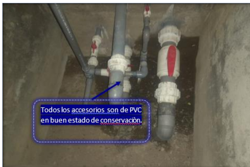
Imagen N° 27 Caja de válvulas del reservorio N°01 de la localidad de Llamacancha
