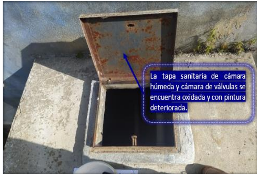
Imagen N° 37 Caja de válvulas con tapa metálica del reservorio N°01 de la localidad de San Juan de Miraflores
