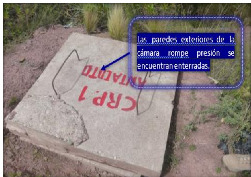
Imagen N° 68 Paredes exteriores de la Cámara rompe presión - localidad de Antacoto
