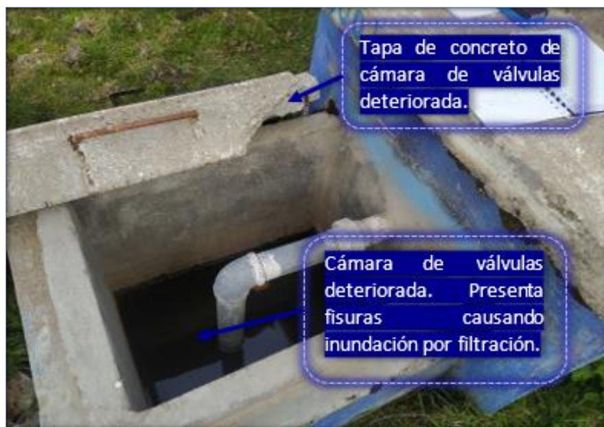
Imagen N° 33 Cámara húmeda de la Captación denominada CHUWIN HUAYCCO de la localidad de San Juan de Miraflores
