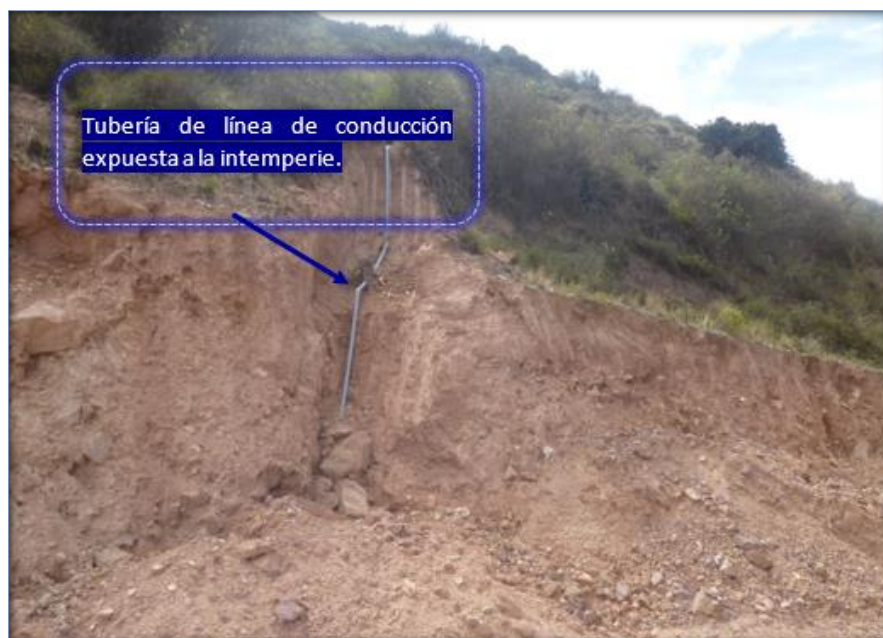
Imagen N° 66 Trayecto de línea de conducción expuesta - localidad de Antacoto
