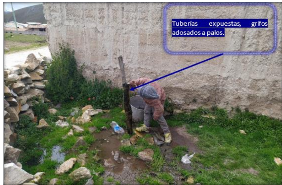
Imagen N° 30: Conexiones DOMICILIARIAS de Llamacancha
