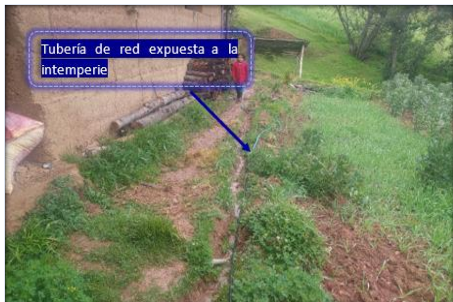
Imagen N° 74 Línea de distribución expuesta sin recubrimiento de material no recomendada
