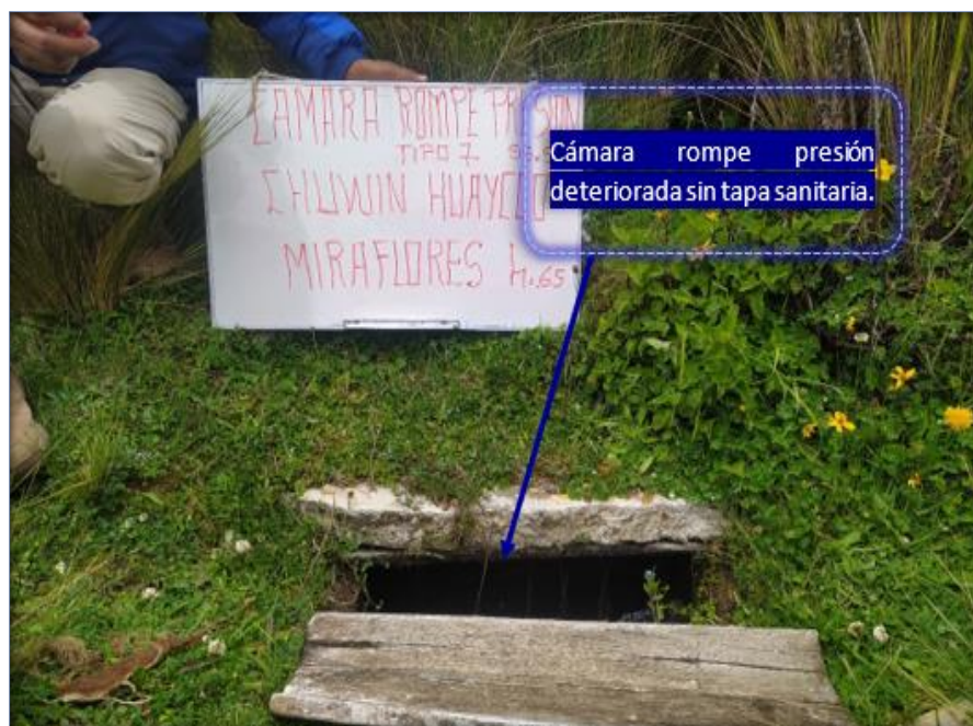
Imagen N° 35: Cámara rompe presión de la localidad de San Juan de Miraflores
