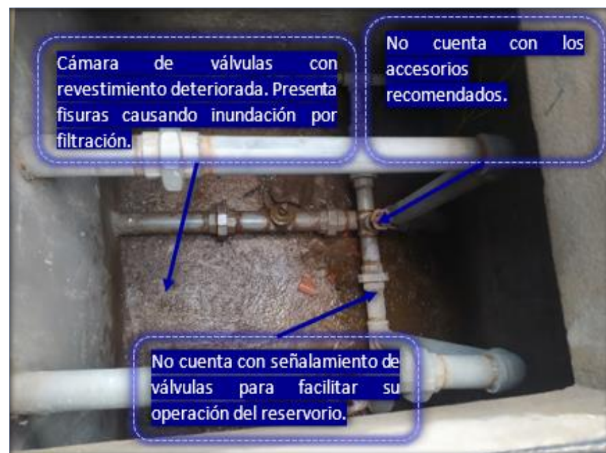
Imagen N° 50 Caja de válvulas del reservorio N° 01 de la localidad de Villa la Libertad
