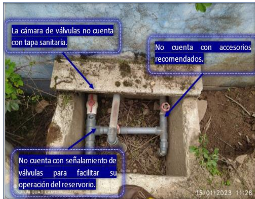
Imagen N° 72 Caja de válvulas del reservorio de la localidad de Antacoto
