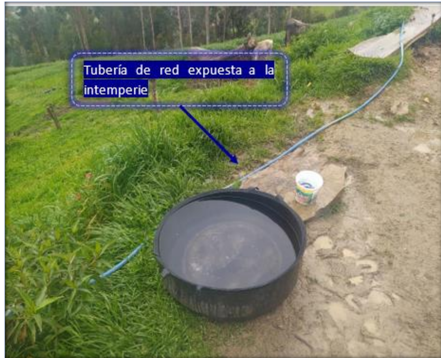
Imagen N° 75 Tramo de Line de distribución expuesta sin recubrimiento de material no recomendada
