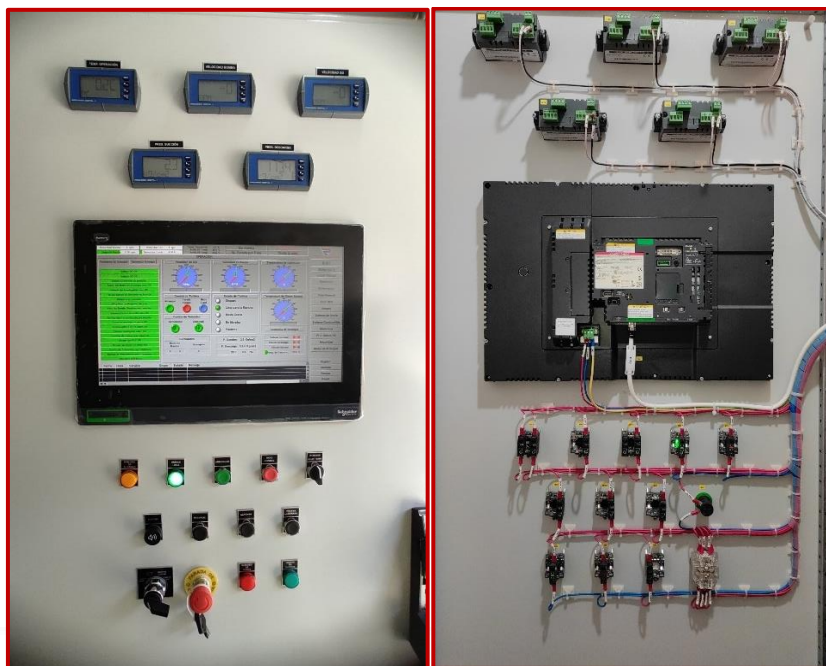
Figura N° 6. Montaje HMI Puerta Gabinete
