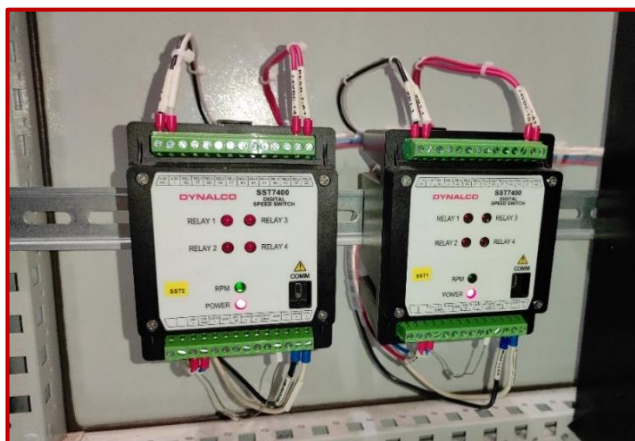
Figura N° 2 - Instalación y cableado de equipos marca Dynalco SST 17400
