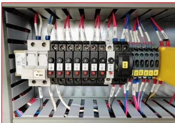
Figura N° 4. Circuito Alimentación – 24Vdc
