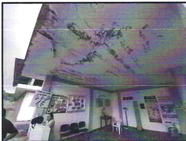
FOTO 04 – (16-03-2023) Se observa en la imagen el cielorraso en pésimo estado debido a las filtraciones de agua de lluvia por la mala colocación de contrapiso en la parte superior del techo de concreto.
