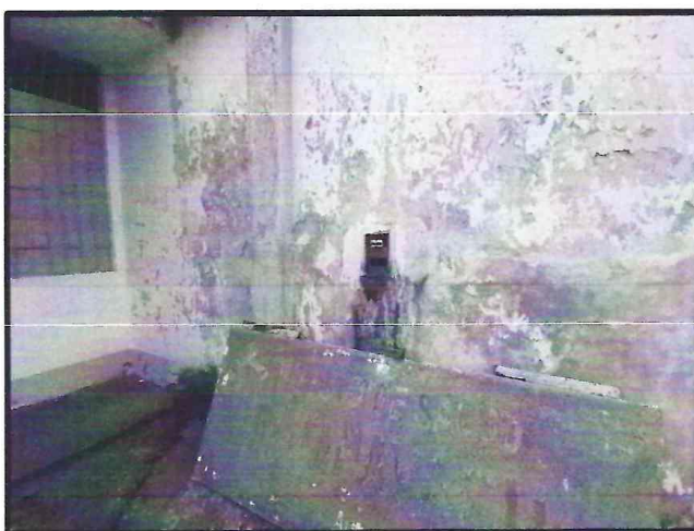
FOTO 06 – (16-03-2023) Se observa en la imagen la caja de distribución general el cual no esta protegido e ingresa agua de lluvia siendo un peligro para los beneficiarios y personal del establecimiento.
