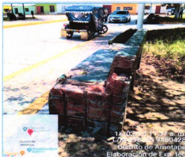
Fotografía N°03: Bancas existentes construidas de material de ladrillo, se encuentran en estado de deterioro, por lo que se propone su demolición.
