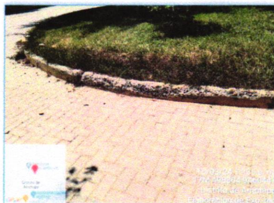
Fotografía N°02: Sardinell peraltado en estado de deterioro, por lo que se propone su demolición y reposición del mismo, según detalle de planos
