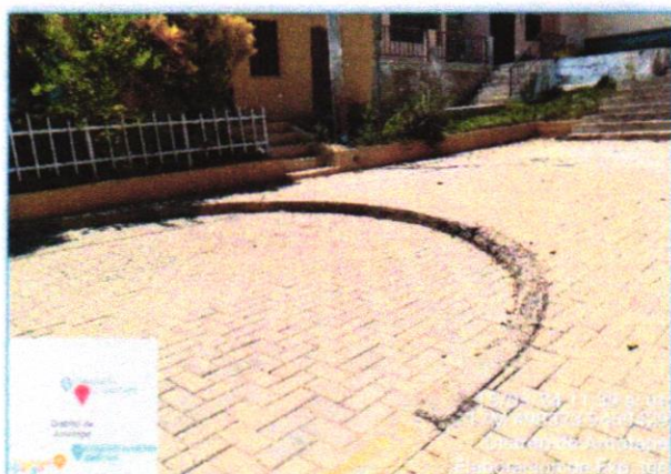
Fotografía N°04: Tal como se aprecia en la fotografía se visualiza el sardinel sumergido en malas condiciones, por lo que se propone su demolición y
