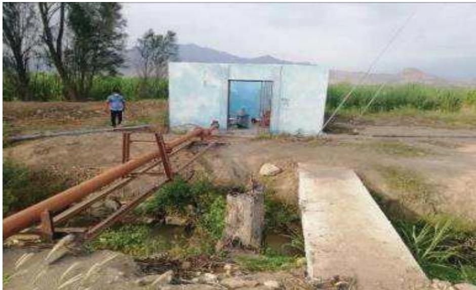
**ESTRUCTURAS DE ALMACENAMIENTO CISTERNA** El sistema cuenta con una cisterna de concreto armado ubicada al pie del tanque elevado y adyacente a la vía pública, esta estructura constituye un peligro a peatones, vehículos y animales ya que no cuenta con las tapas necesarias, tal como se aprecia en la imagen siguiente. Así mismo se resalta que la estructura se encuentra inoperativa.
