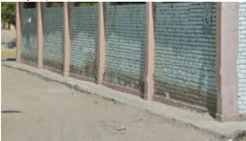
Ilustración N° 25. Calle SAN JUAN– margen Derecha, Vereda de tránsito peatonal en mal estado con presencia de grietas y sin respetar criterios técnicos, de acuerdo a la evaluación realizada en campo.
