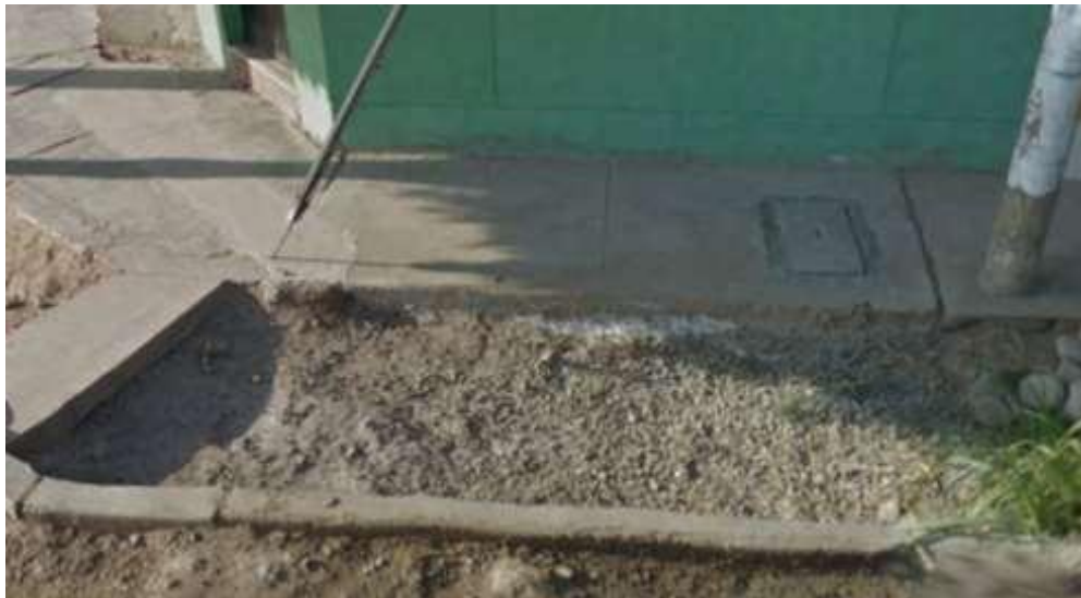
Ilustración N° 23. CALLE CHICLAYO- Cuadra 01– margen, Izquierdo, Vereda de tránsito peatonal en mal estado con presencia de grietas y sin respetar criterios técnicos, de acuerdo a la evaluación realizada en campo.
